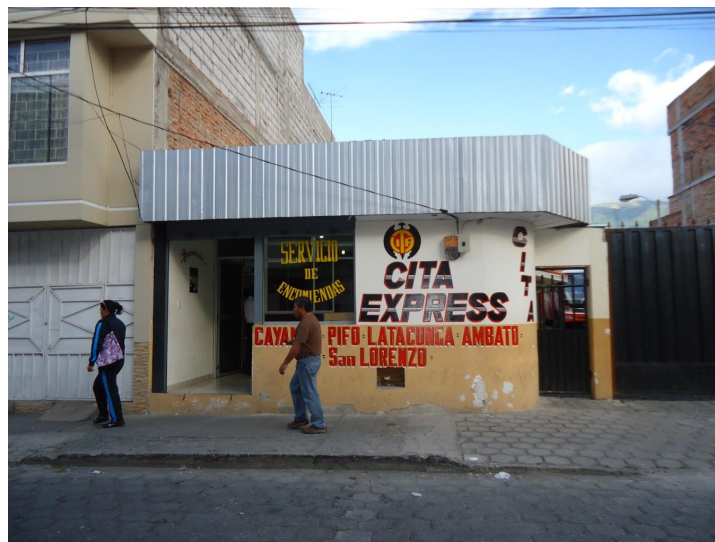
Gráfico 18: Exteriores de la oficina de encomiendas de la ciudad de Ibarra
