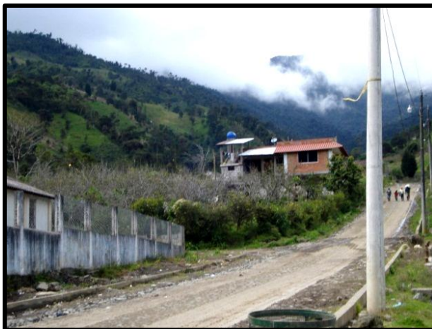
Imagen No.1: Postes de Alumbrado Público
