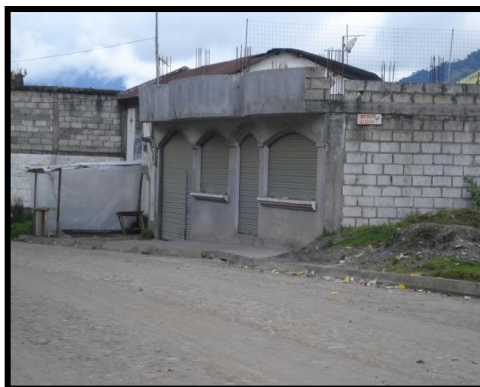
Imagen No.22: Restaurante Vista Externa
