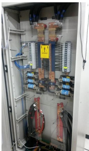
Figura 3. 11 Posición asignada rectificador y barra a tierra. Fuente: Investigador
