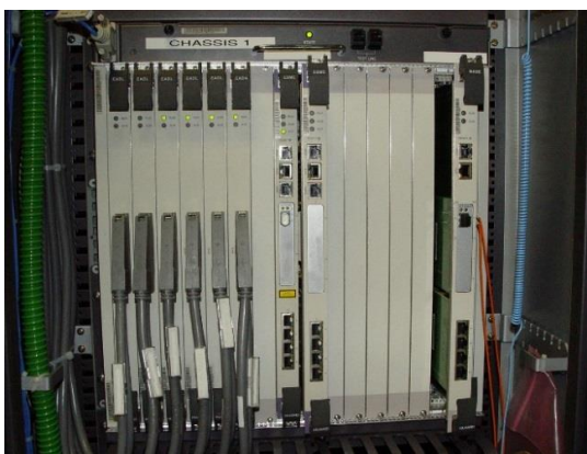
Figura 3. 5 DSLAM MA5600 Fuente: Investigador
