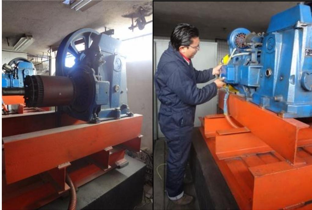
**Figura 3.7.** Motor del Ascensor.
