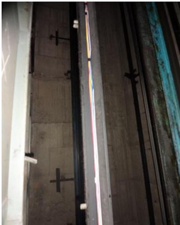
**Figura 3.3.** Cables de comunicación entre el tablero de control que está en el cuarto de máquinas hasta la cabina.
