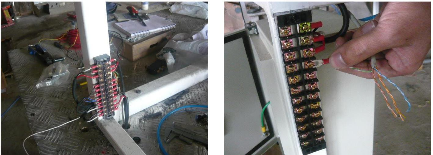
**Fig 3.107** Regleta de conexiones
