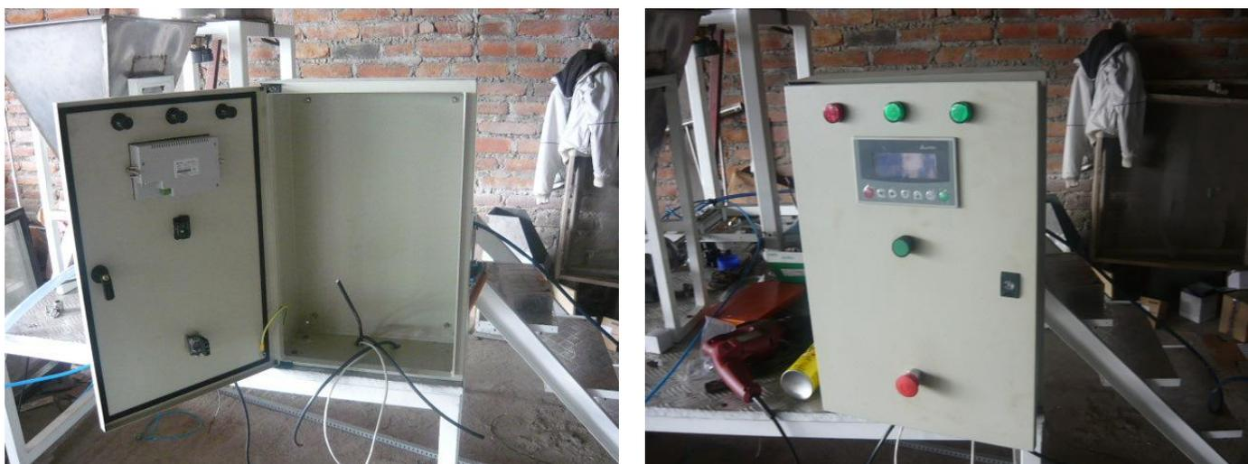
Fig 3.105 Instalación y conexiones del tablero de control
