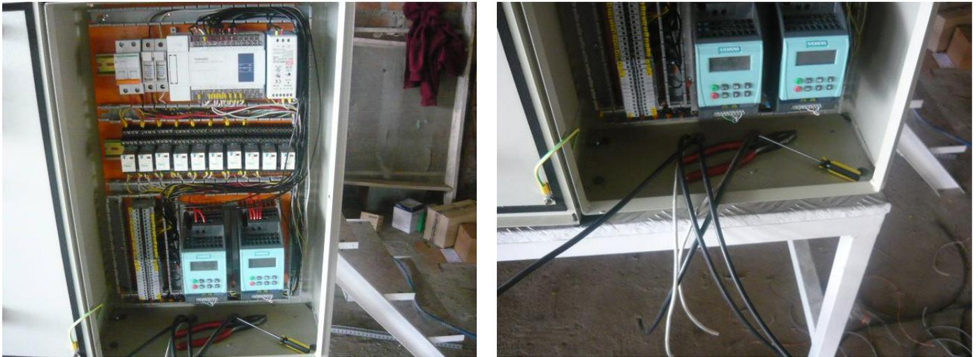
**Fig 3.106** Conexiones e instalación del tablero de control
