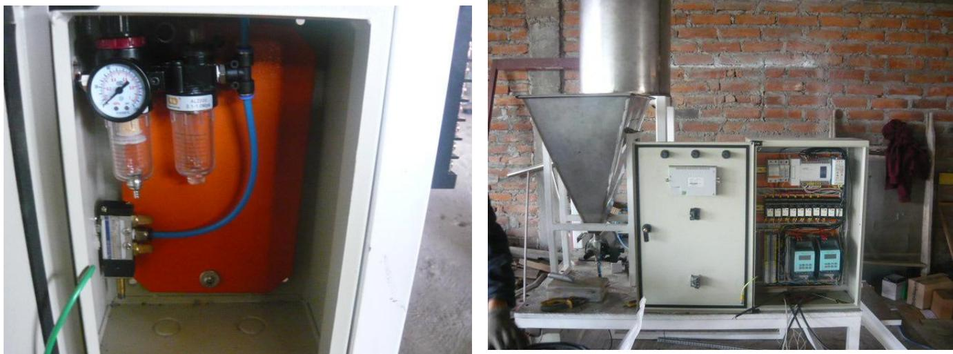
**Fig 3.108** Instalación de la unidad de mantenimiento neumático y tablero de control
