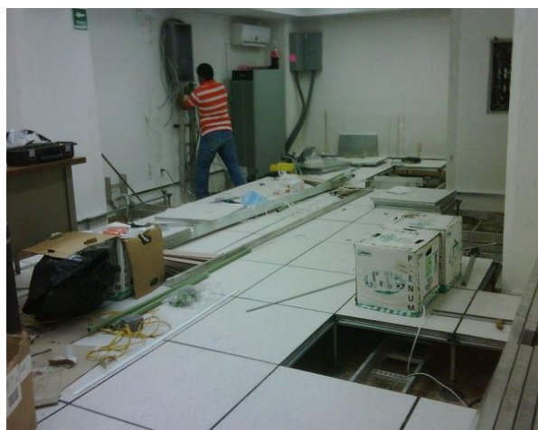
Figura 42 Colocación de Piso Falso Fuente: (Elaboración Propia, 2014)
