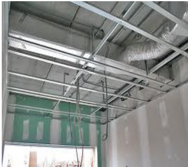
Figura 43 Instalación de Techo Falso Fuente: (Elaboración Propia, 2014)
