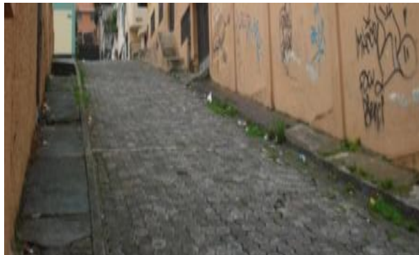
Anexo 6: Basura, común en la calle La Bota
