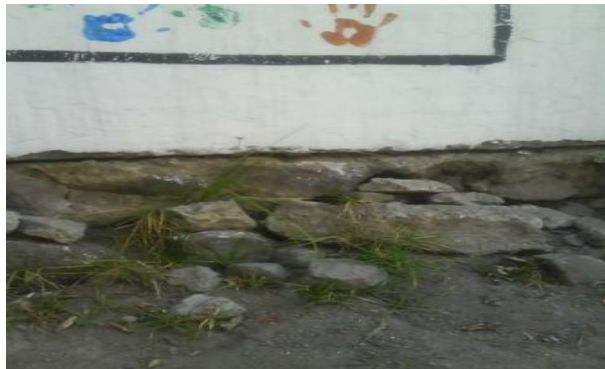
Anexo 8: Escuela República de Italia. Cimientos del muro este, un hueco hecho por los alumnos, ha sido tapado con piedras para que los niños no se escapen.
