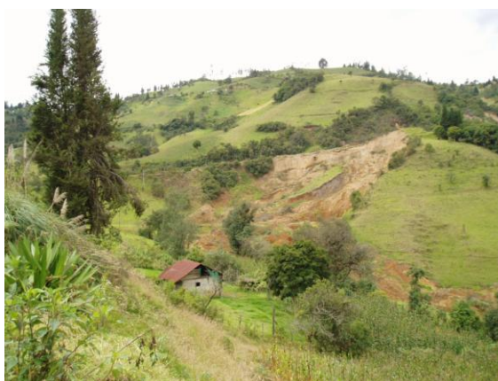
FOTO 6.- Deslizamiento PR 2 (Abscisa 41+000) visto desde la curva al Oeste de la vía.
