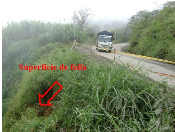
FOTO 15.- Taludes inferiores de la mesa de la vía en el sitio PR 65+000
