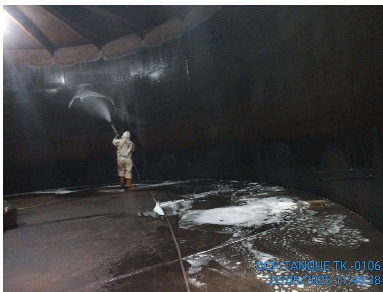
Ilustración 7. Desengrasado e hidrolavado.
