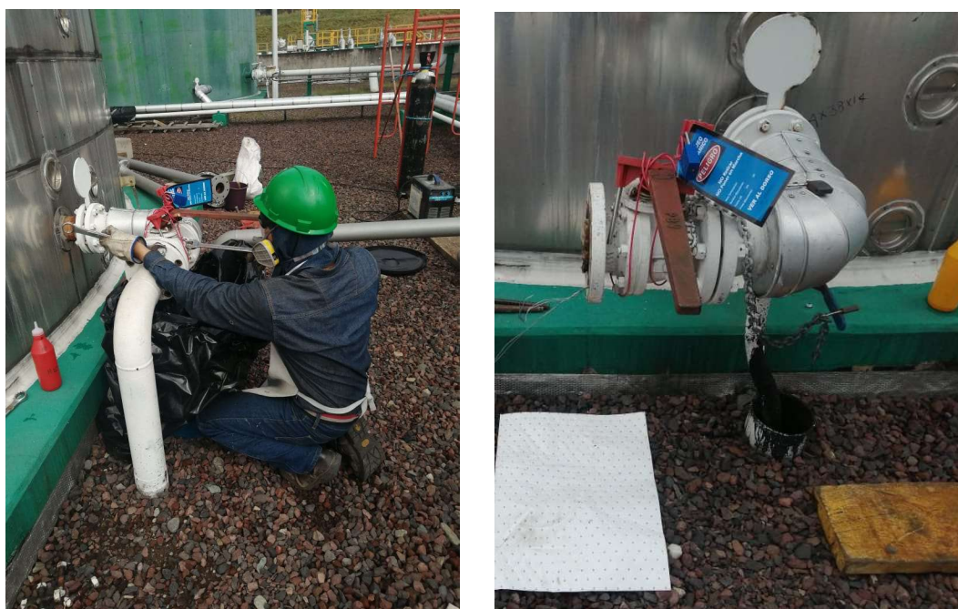
Ilustración 2. Bloqueo, etiquetado y liberación de presión.
