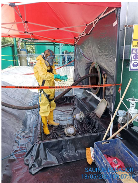
Ilustración 5. Remoción de crudo remanente.
