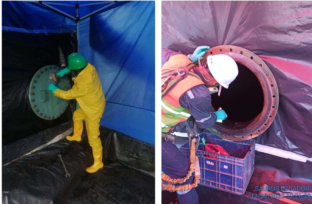
Ilustración 4. Apertura de manhole de cuerpo y desgasificación.
