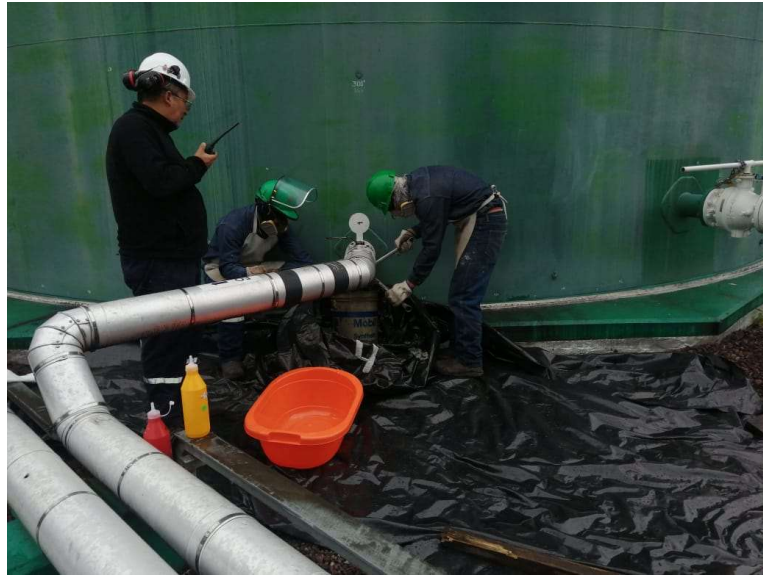
Ilustración 1. Drenaje inicial de tanques
