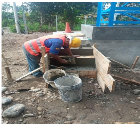
Ilustración 7. Puesto de trabajo de Albañil
