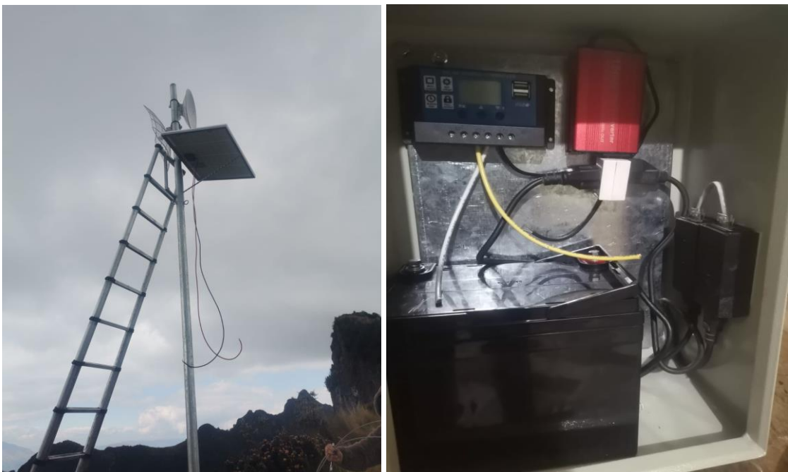
Figura. 27 Colocación de equipos
