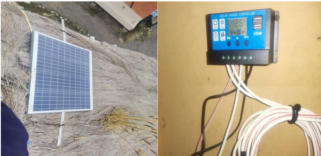
Figura. 29 Colocación de sistema fotovoltaico en las cabañas
