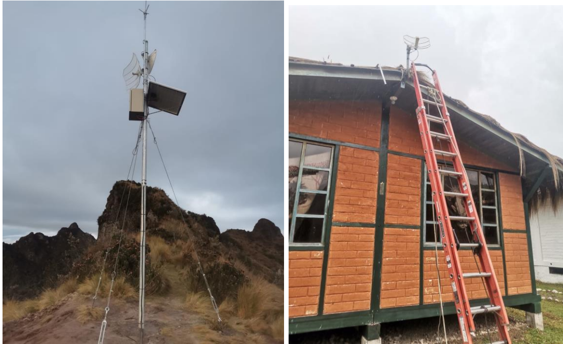
Figura. 28 Torre totalmente armada
