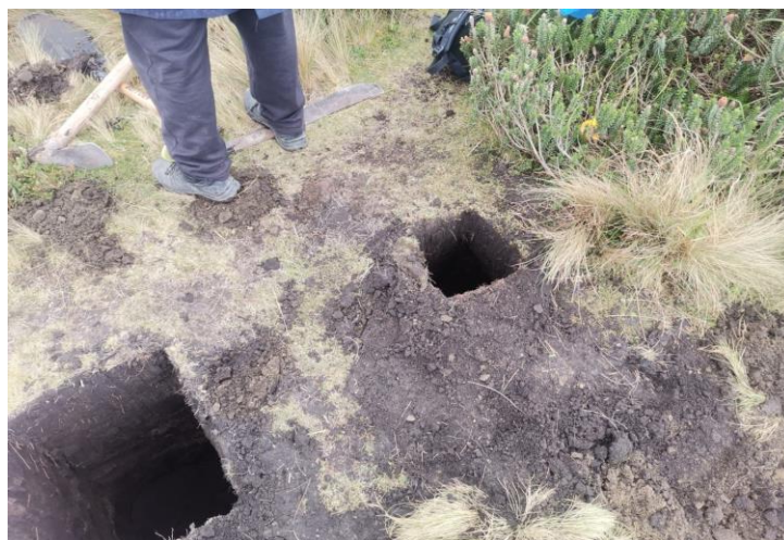
Figura. 25 Perforación para fundir bases
