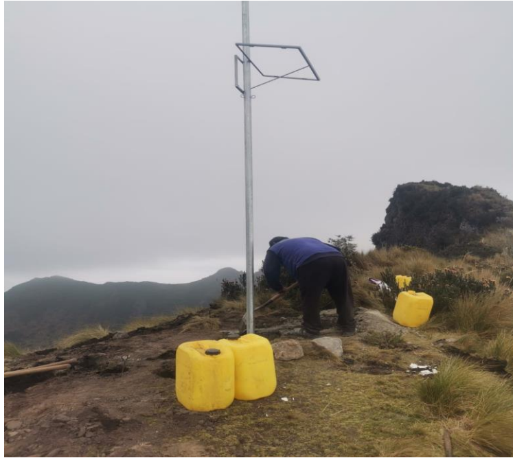
Figura. 26 Fundición de base de la torre
