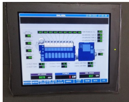
Ventanas del HMI para monitoreo de temperaturas de salida de gases de los cilindros
