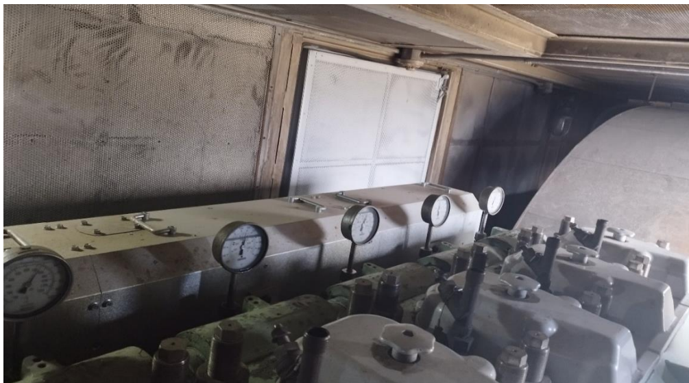
Figura 3: Termómetros de glicerina para medición de temperaturas de gases de combustión del motor Hyundai 9H21/32
