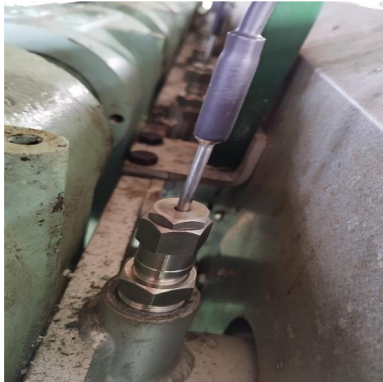
Figura 36: Instalación de la termopar tipo K en el pozo de medición
