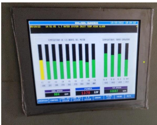
Ventanas del HMI para monitoreo de temperaturas de salida de gases de los cilindros
