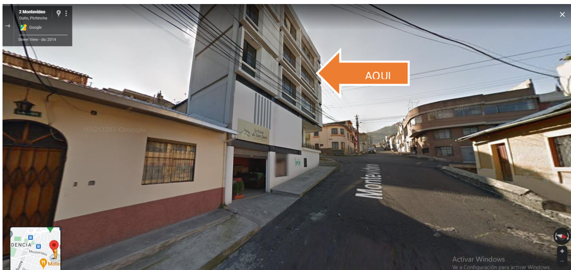
Figura 11 Ubicación Barrio San Juan
