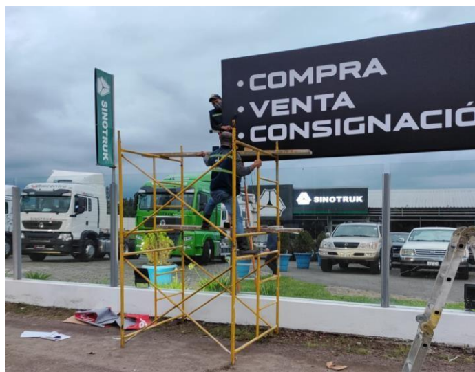
Figura 17 Instalación en Altura - Realizado por (Montenegro D, 2022)
