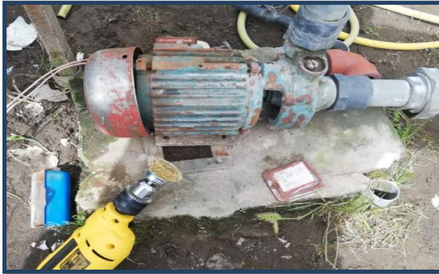
Figura 4.7 Mantenimiento de la bomba de agua.
