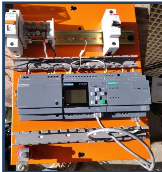
Figura 4.12 Montaje previo. Fuente: Autor.
