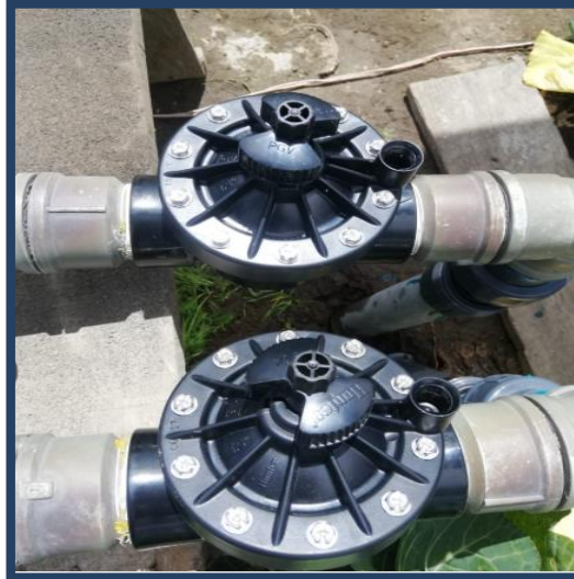
Figura 4.10 Electroválvulas instaladas.
