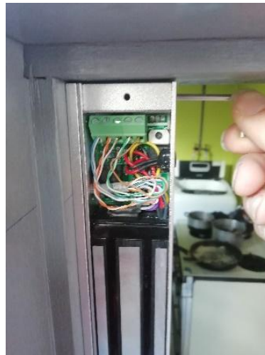
Figura 28: Instalación cerradura electromagnética Fuente: (SECO-LARM, 2020)
