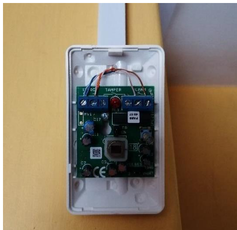
Figura 24: Instalación de sensor PIR. Fuente: (Risco Group, 2020)
