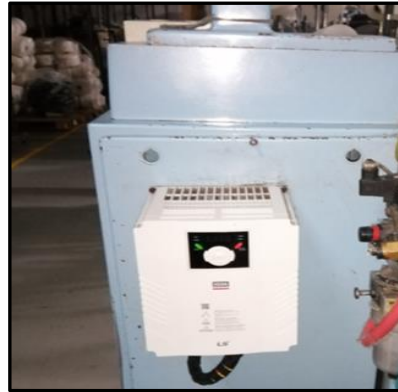
Figura. 4. 15. Instalación del variador LG
