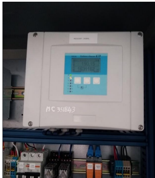
Figura. 3.2. Medidor de caudal Endress + Hauser Fuente: Elaborado por el autor
