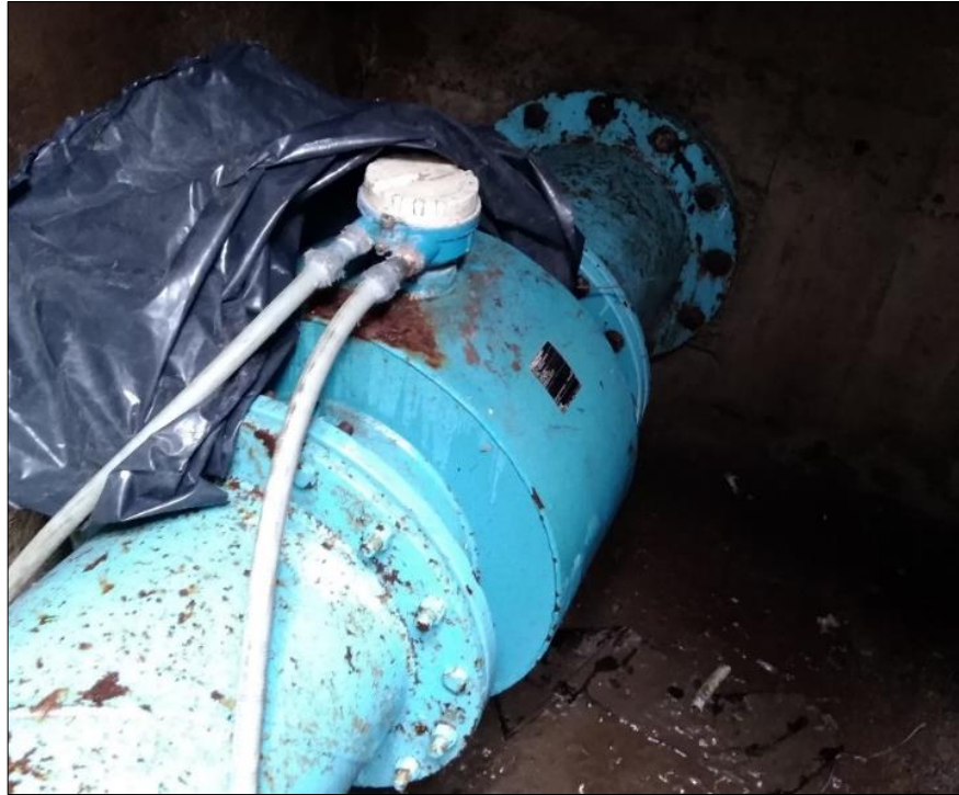
Figura. 3.9. Sensor del caudalímetro de la línea San Juan Promag W Fuente: Elaborado por el autor
