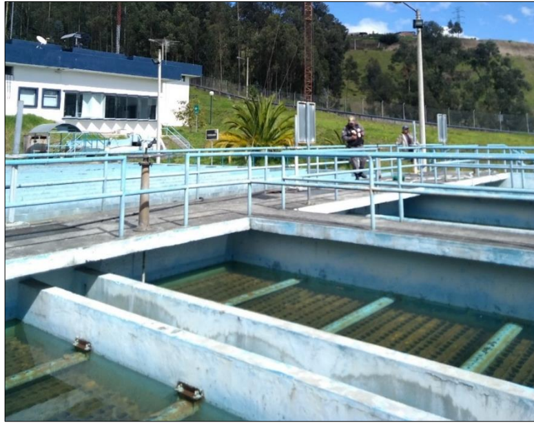
Figura. 1.3. Sedimentador Fuente: Elaborado por el autor
