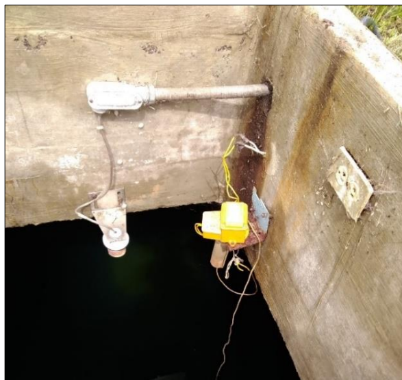
Figura. 3.13. Sensor ultrasónico de la cámara Santa Mónica Fuente: Elaborado por el autor
