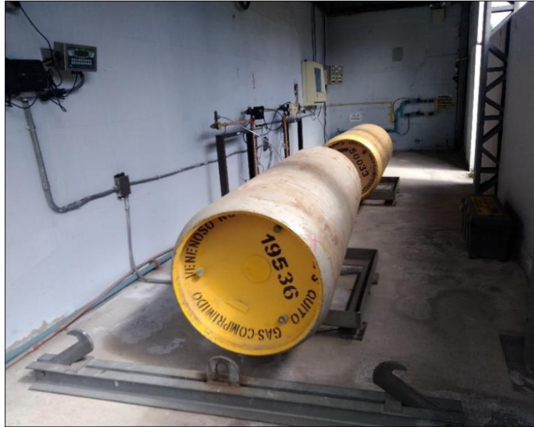
Figura. 1.5. Dosificación de contenedores de cloro gas de 907 kg Fuente: Elaborado por el autor
