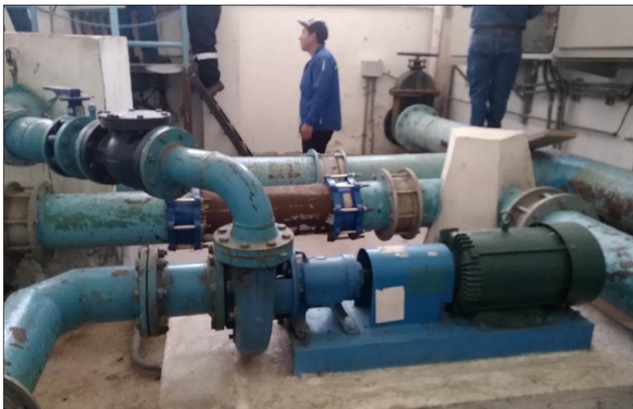
Figura. 3.7. Bomba centrífuga Fuente: Elaborado por el autor
