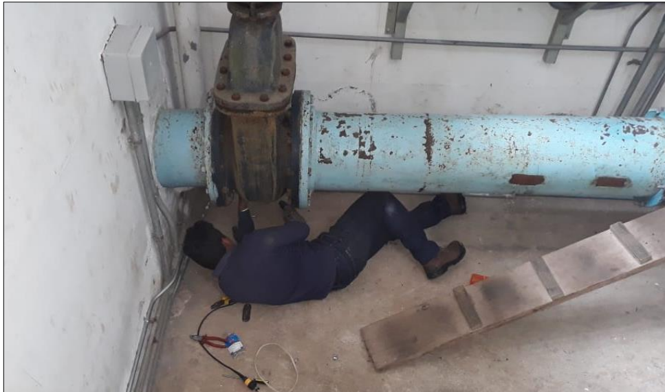
Figura. 4.3. Instalación de tuberías conduit Fuente: Elaborado por el autor
