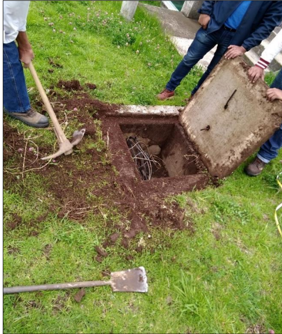
Figura. 4.1. Inspección de ductos soterrados Fuente: Elaborado por el autor
