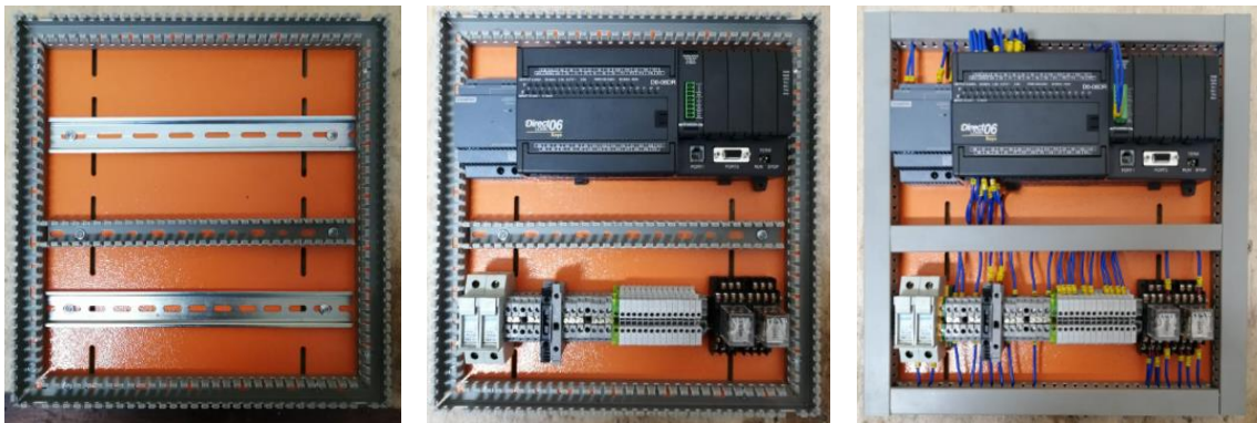
Figura 4.1 Proceso de construcción del doble fondo del gabinete
