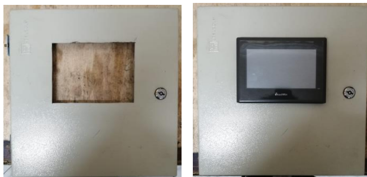
Figura 4.2 Proceso de construcción del gabinete eléctrico frontal
