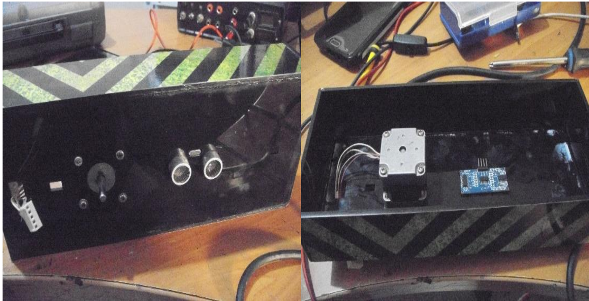
Figura 4.10 Instalación de HC-sr04
