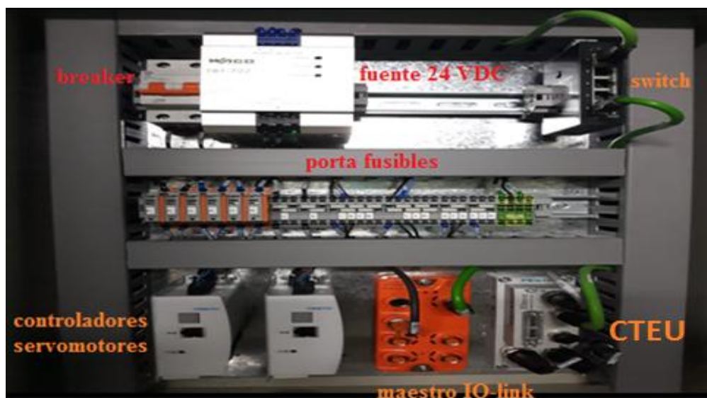
Figura. 4.8. Implementación del tablero eléctrico
