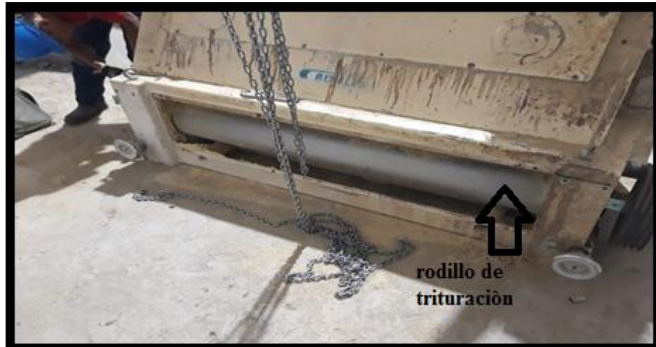
Figura. 4.5. Implementación y desmontaje volantes de calibración antiguos
