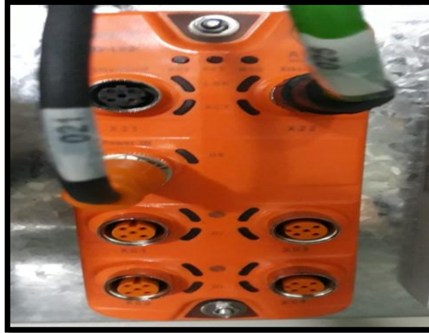
Figura. 4.9. Implementación del maestro IO-link al tablero eléctrico
