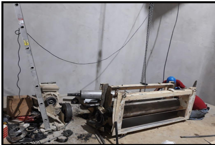
Figura. 4.3. Implementación y desmontaje de rodillos trituración
