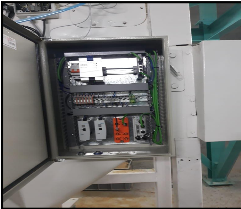
Figura. 4.15. Implementación del tablero de control eléctrico
