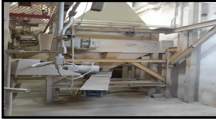
Figura. 4.1. Implementación y desmontaje del equipo
