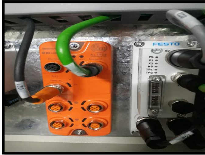
Figura. 4.12. Implementación del maestro IO-link
