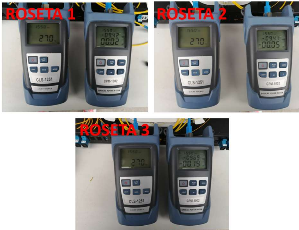
Figura 4.39 Pruebas de medidas de potencia en enlaces
