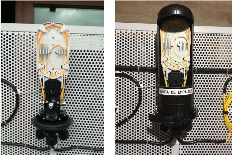
Figura 4.29 Empalme por fusión en manga de empalmes
