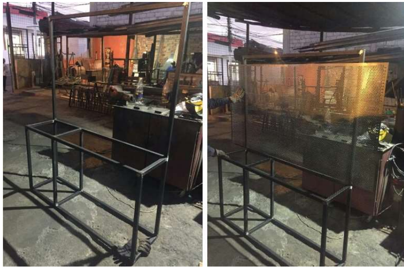
Figura 4.10 Proceso de construcción del módulo experimental
