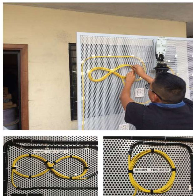
Figura 4.16 Instalación de reservas de fibra óptica
