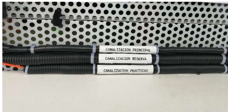
Figura 4.13 Instalación de rutas
