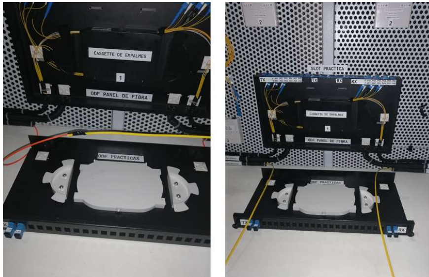
Figura D.1: Guía plástica para pasar el cable de fibra óptica por la ruta predeterminada
