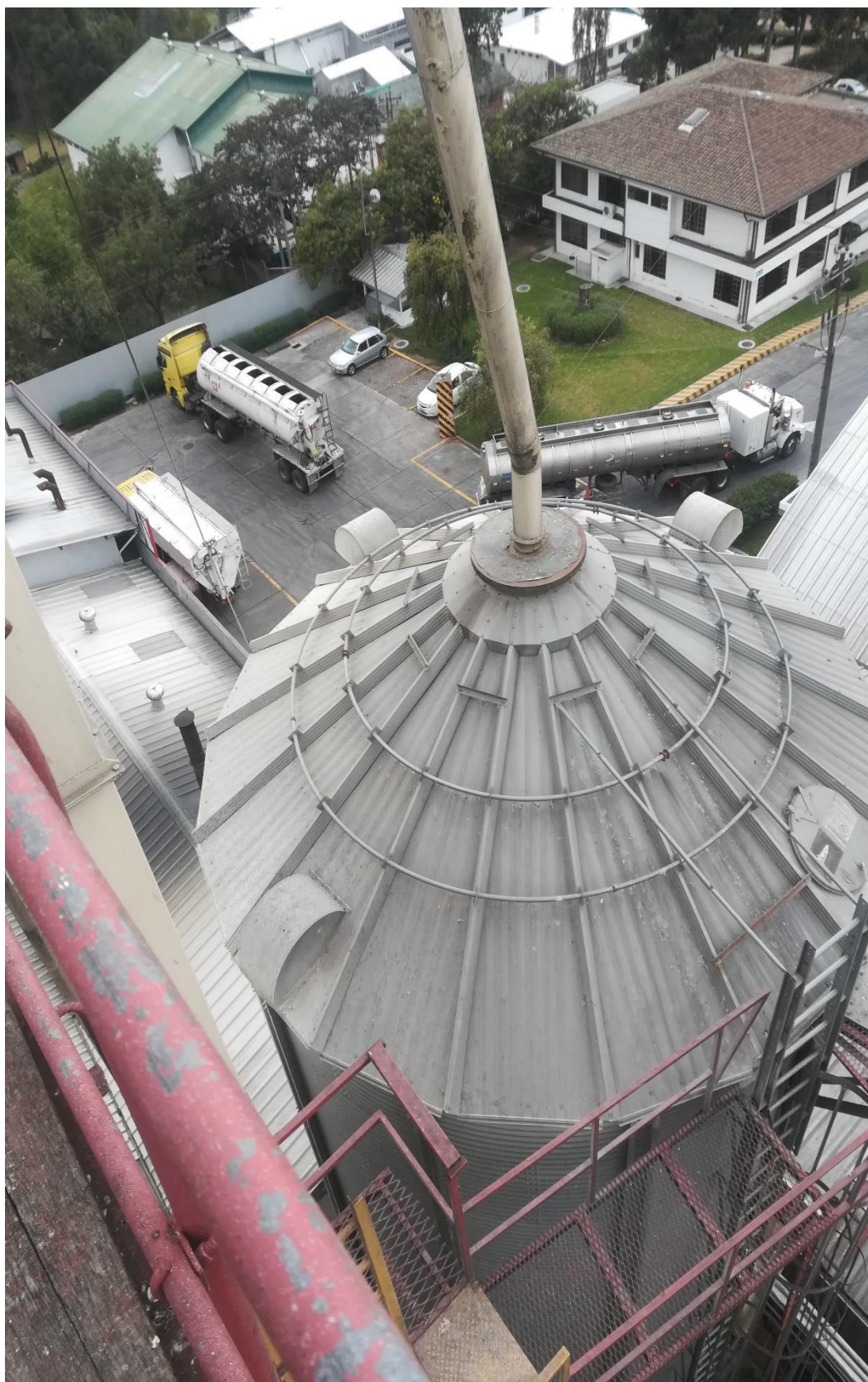
ANEXO 2 vista superior de silo de almacenamiento de trigo.
