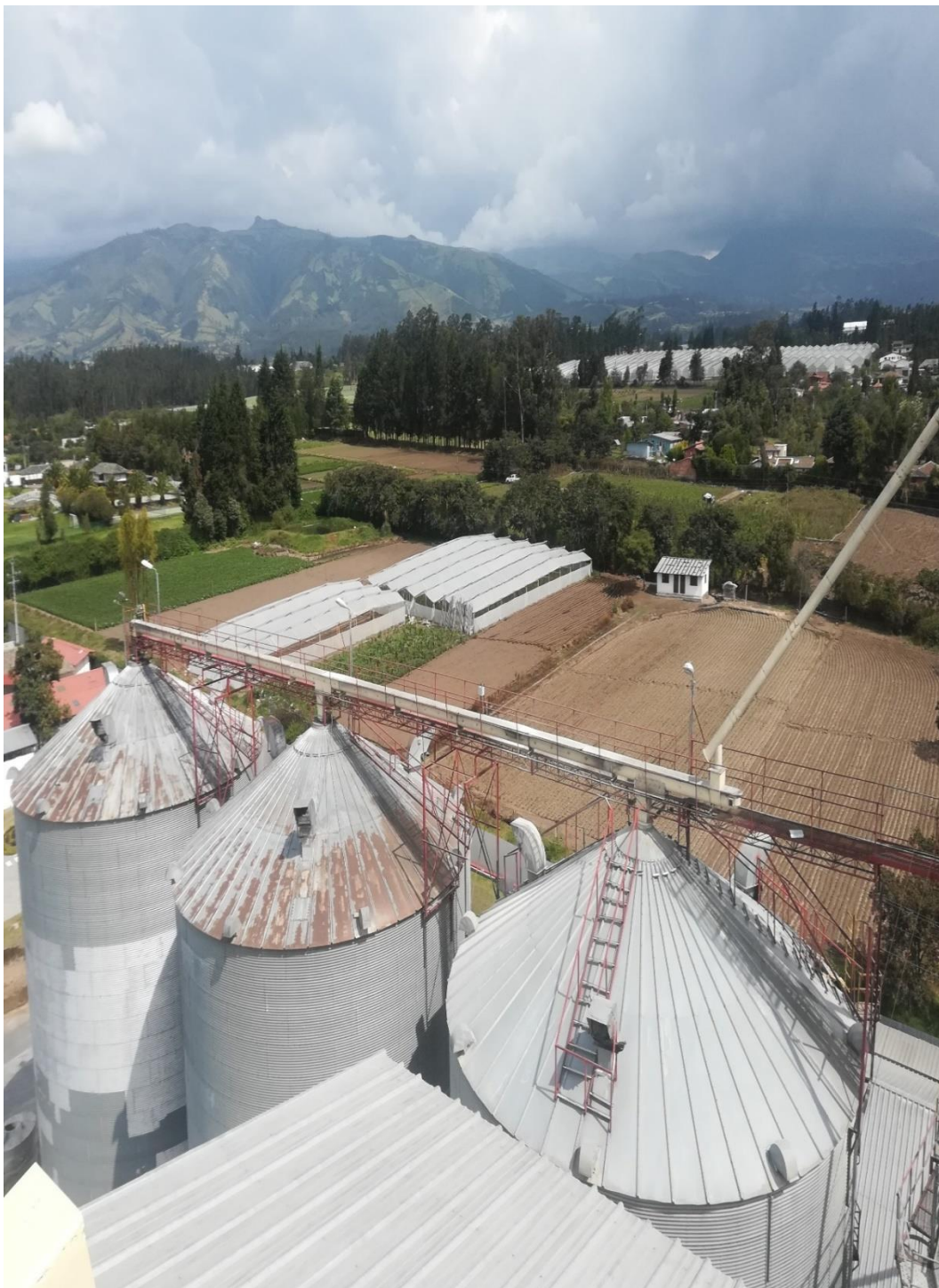
ANEXO 1 vista superior de silos de almacenamiento.
