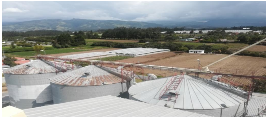
Figura 1.3 Silos de almacenamiento
