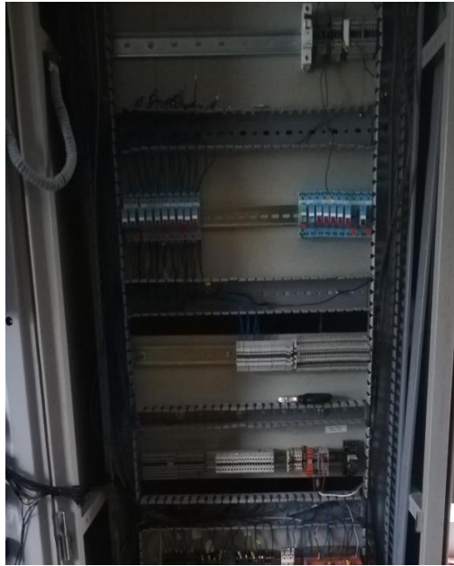
Figura 4.2 Adecuación de tablero
