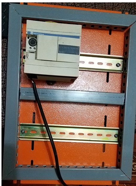
Figura. 4.13 Colocación de elementos de control
