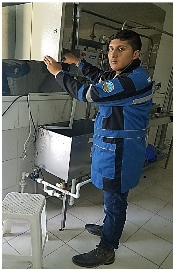
Figura. 4.16 Montaje de tablero nuevo
