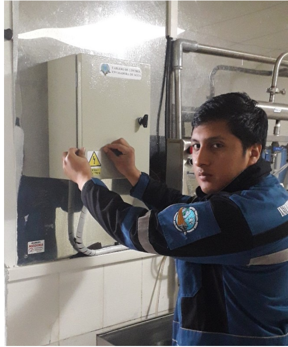
Figura. 4.19 Colocación de señalización
