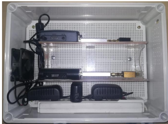
Figura 4. 31 Colocación de los equipos en el Rack.
