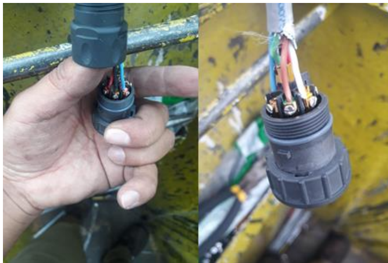
Figura 4.26. Conexión del cable de seguridad al conector de la cámara. Fuente: Elaborado por el autor.
