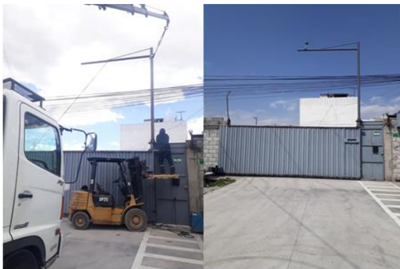
Figura 4.24. Instalación de poste y cámara TrafiCam. Fuente: Elaborado por el autor.
