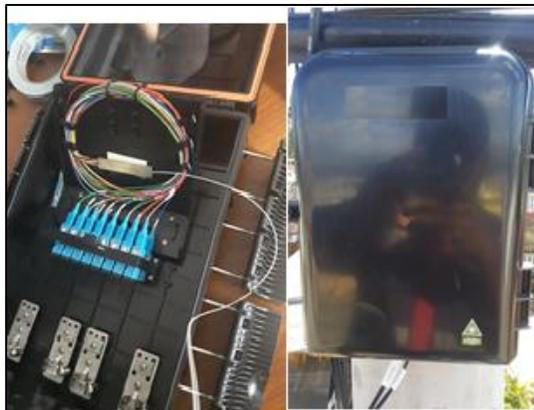
**Figura. 4.28. Instalación de plotter e instalación de caja en poste**
