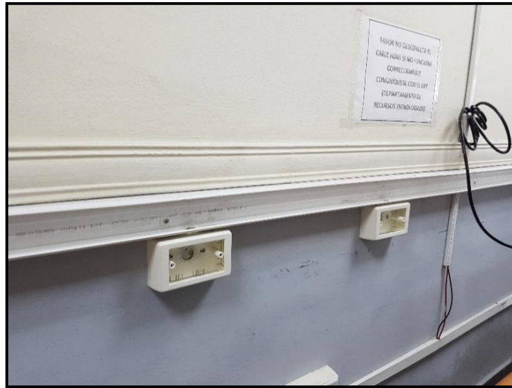
Figura 4.11 Instalación de tomas Elaborado por: El Autor
