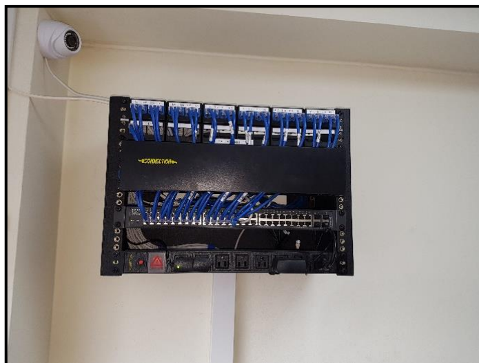
Figura 4.60 Colocación de la tapa del organizador (canaleta) Elaborado por: El Autor
