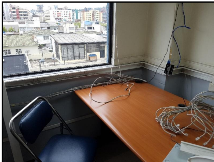
Figura 4.9 Remoción de cableado Elaborado por: El Autor
