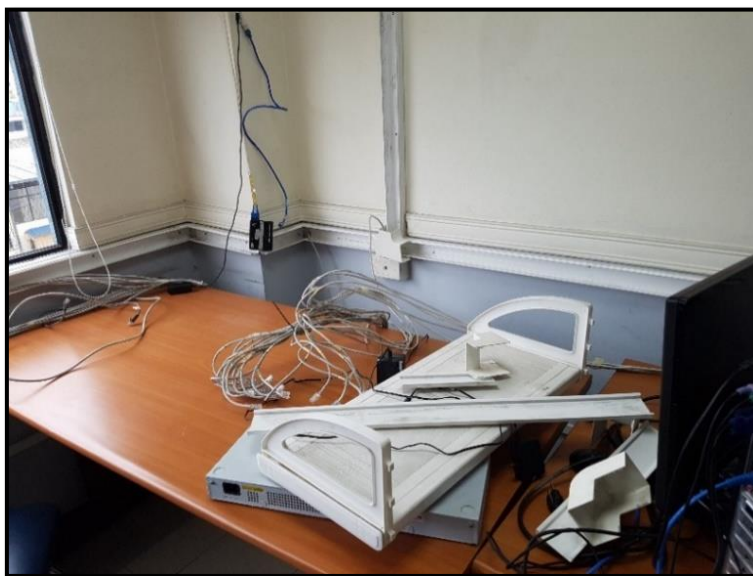
Figura 4.8 Desmontaje de los equipos Elaborado por: El Autor
