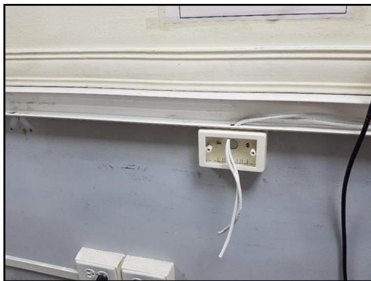
Figura 4.22 Tendido de cable UTP Elaborado por: El Autor
