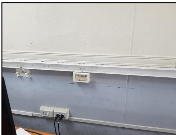
Figura 4.10 Instalación de canaletas Elaborado por: El Autor
