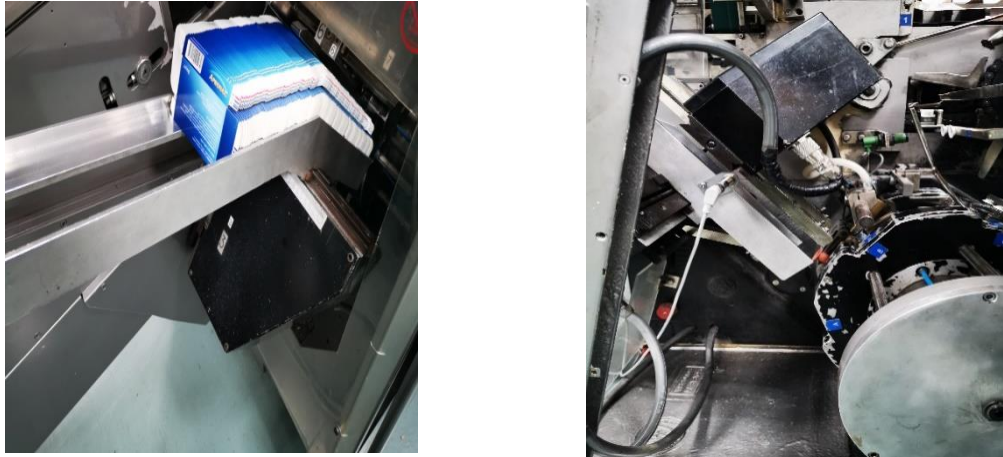
Figura 51 Sensor de detección presencia de Caja (El Autor 2019)
