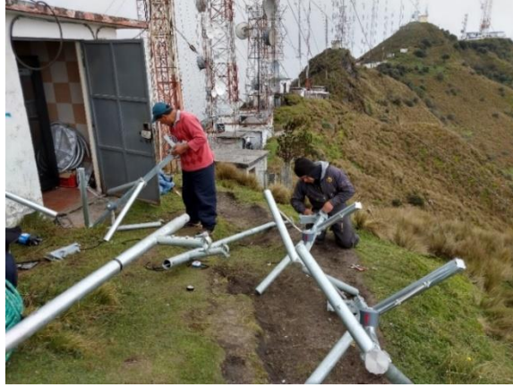
Figura 4. 18 Armado de antenas y herrajes de sujeción.
