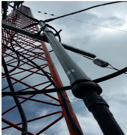
Figura 4. 21 Impermeabilización de conectores del distribuidor
