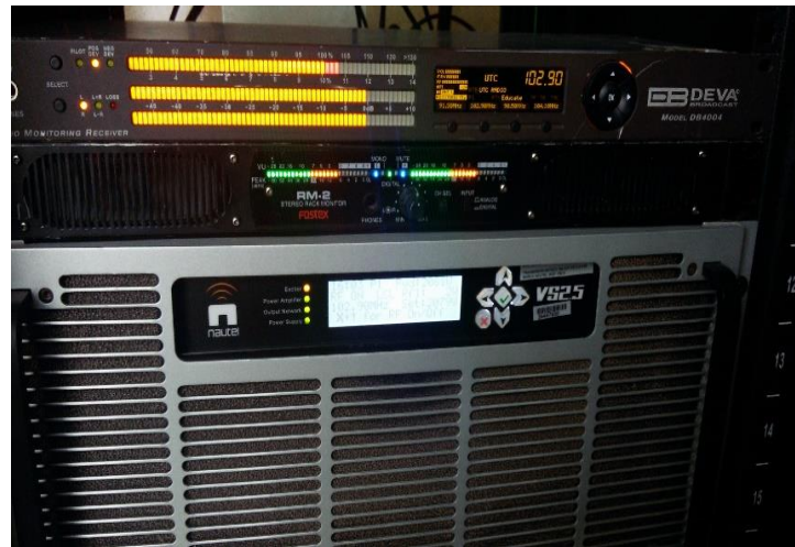
Figura 4. 24 Ajuste de niveles de audio y piloto de estéreo.
