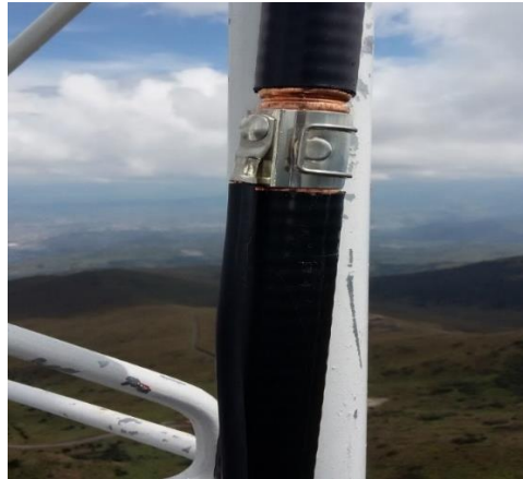
Figura 4. 20 Instalación de grounding kit
