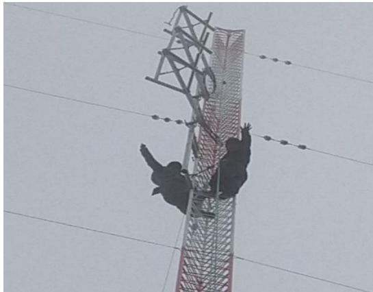
Figura 4. 19 Montaje de antenas en torre.
