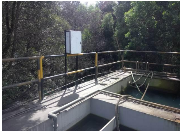
Figura 4.52 . Traslado y colocación. Fuente. Elaborado por el autor.
