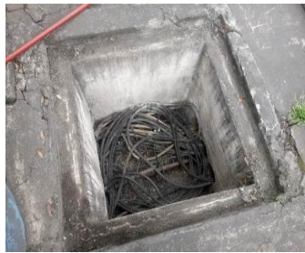
Figura 4. 52. Destapando ductos Fuente. Elaborado por el autor.
