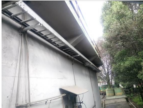
Figura 4. 47. Implementación de canaletas. Fuente. Elaborado por el autor.
