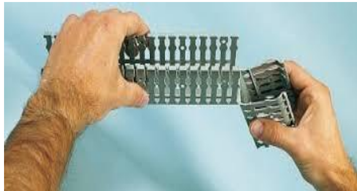
Figura 4. 19. Corte a medidas de canaletas Fuente: SIEMENS. (2012).
