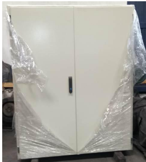
Figura 4. 18. Inspección. Fuente. Elaborado por el autor.
