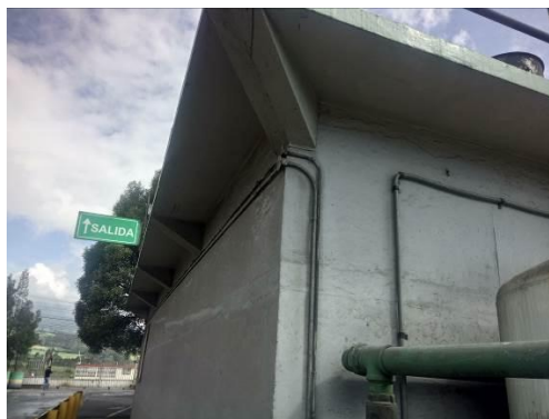
Figura 4. 46. Trazo para perforaciones. Fuente. Elaborado por el autor.
