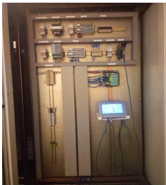
Figura 4. 44. Marcado y etiquetado. Fuente. Elaborado por el autor.
