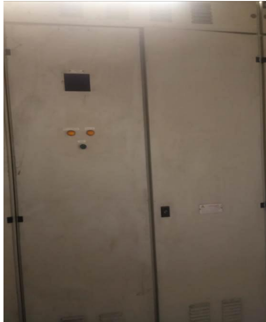
Figura 4. 27. Inspección. Fuente. Elaborado por el autor.
