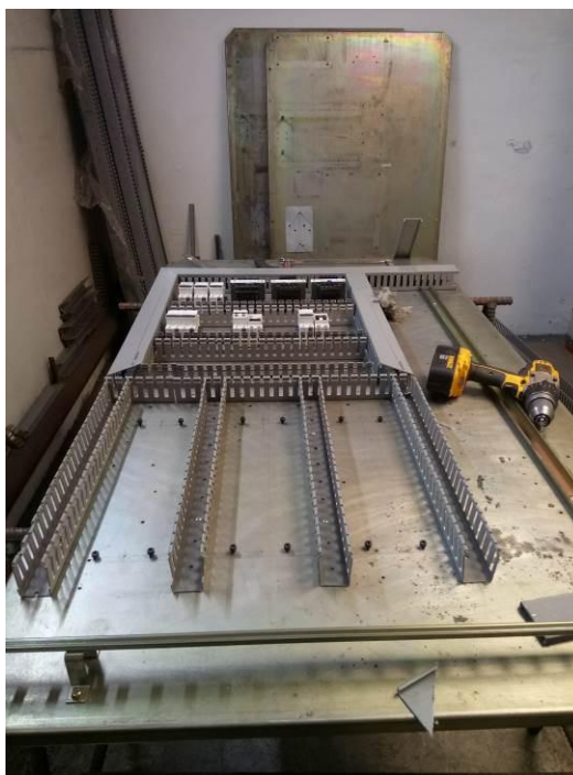
Figura 4.76. Montaje de canaletas Fuente. Elaborado por el autor.
