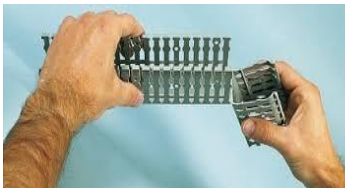
Figura 4. 29. Corte de canaletas Fuente. Elaborado por el autor.
