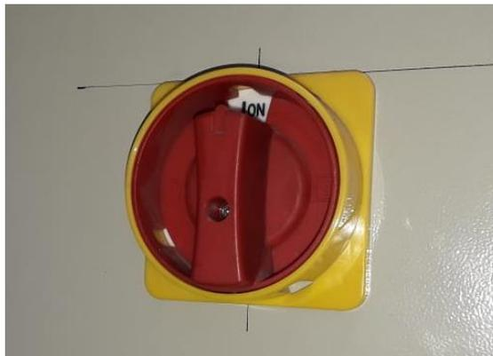
**Figura 1.12: Interruptor seccionador trifásico**
