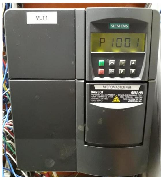
Figura 1.22: Variador de frecuencia siemens micromaster 420
