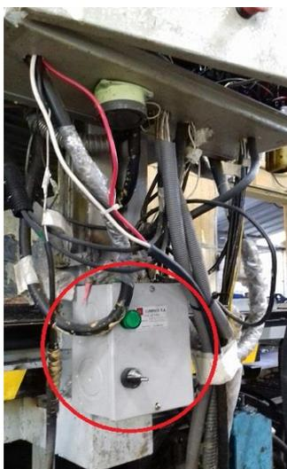
**Figura 4.16: Tablero adicional viejo y cables sueltos**
