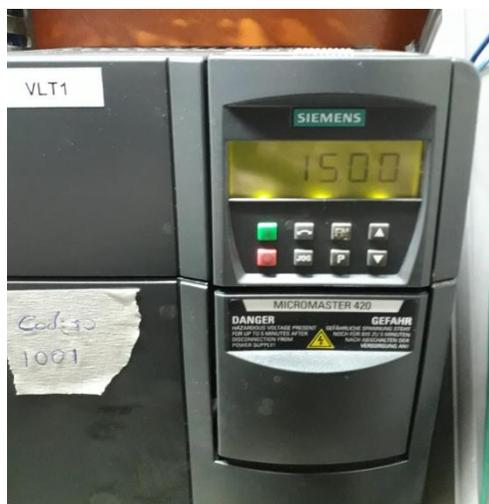
**Figura 3.3: Cambio de velocidad en el variador de frecuencia**
