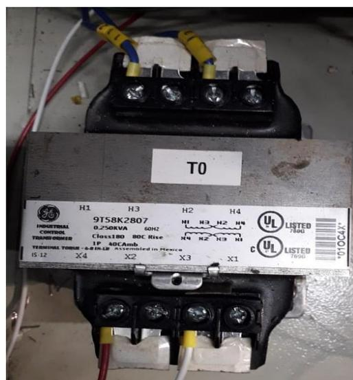
Figura 1.24: Transformador monofásico 250VA, entrada 220V, salida 110V
