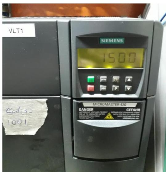
**Figura 7: Cambio de velocidad en el variador de frecuencia**
