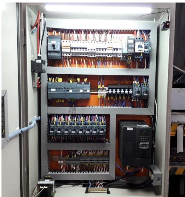
**Figura 4.3:** Elementos eléctricos montados dentro del tablero de control
