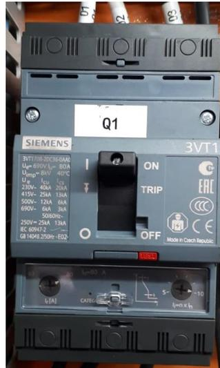
**Figura 1.13: Interruptor termomagnético trifásico**
