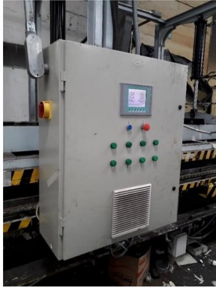
**Figura 4.18: Vista externa del tablero nuevo de control**
