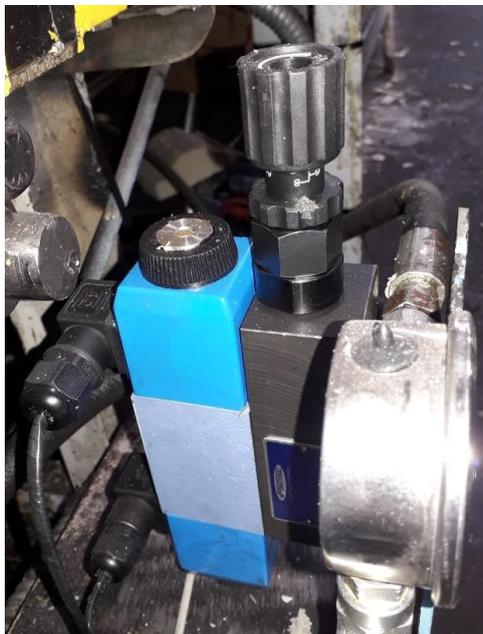
**Figura 1.21: Electroválvula dos posiciones para elevación mesa del transportador**
