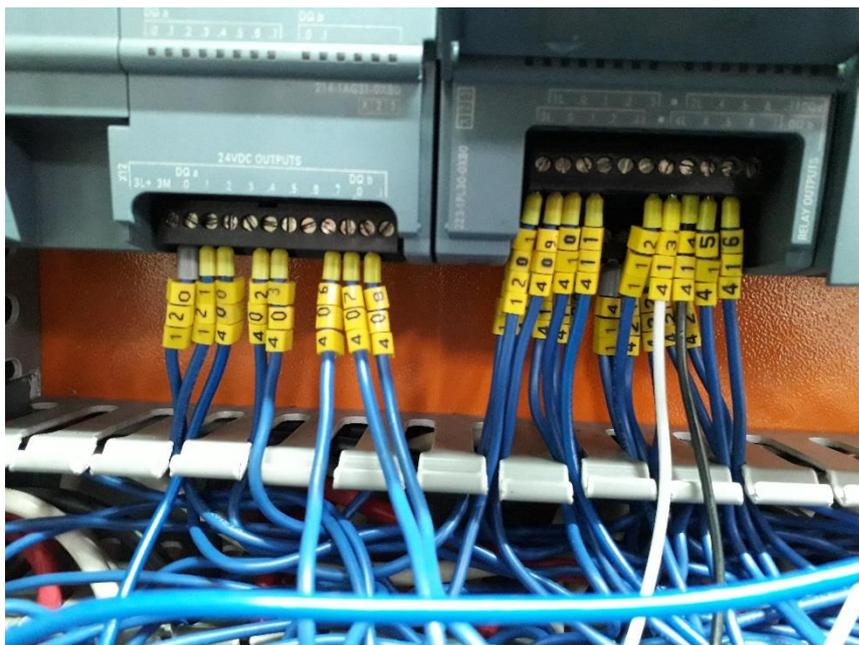
**Figura 4.6: Identificación de cables de las conexiones eléctricas.**
