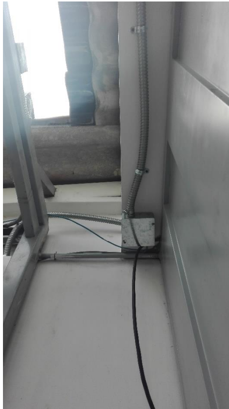
Figura 4.28 Instalación manguera BX Planta Alta 2.
