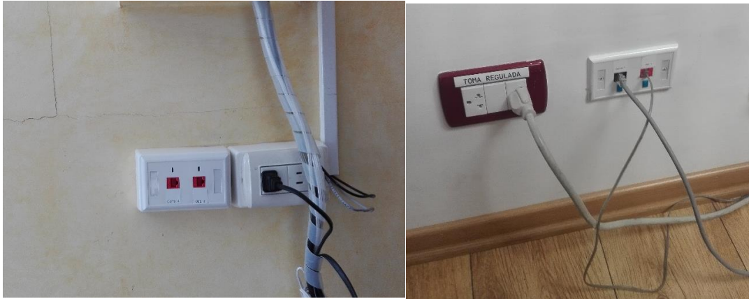
Figura 4.35 Instalación de puntos de red.
