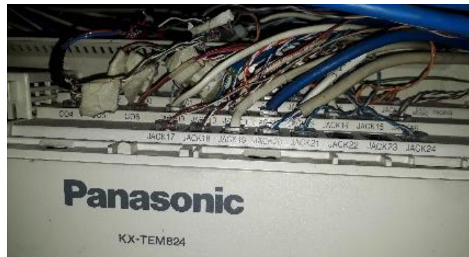
Figura 3.1 Central Telefónica
