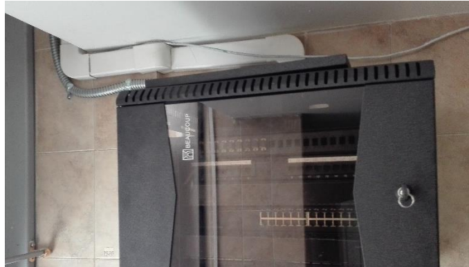
Figura 4.25 Instalación de canaletas y manguera BX.
