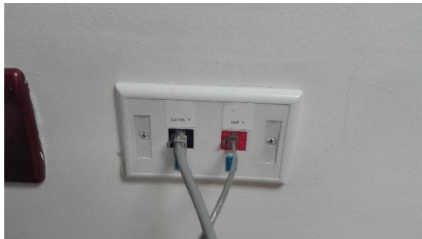
Figura 4.36 Instalación de puntos de red dentro de cajetín.
