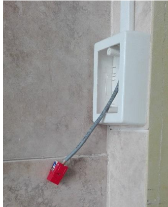
Figura 4.37 Instalación de puntos de red en cajas de exón.
