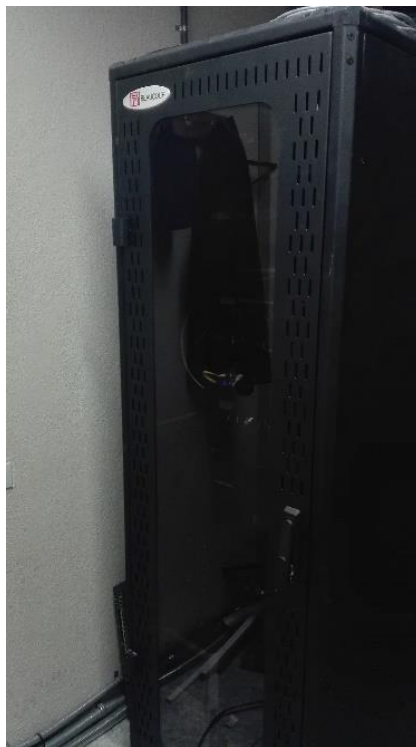
Figura 4.17 Racks instalado planta baja.
