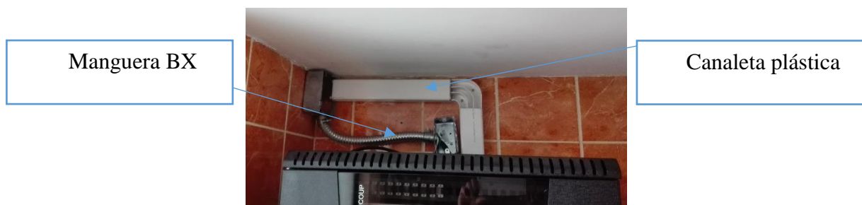
Figura 4.24 Instalación de canaletas y manguera BX.
