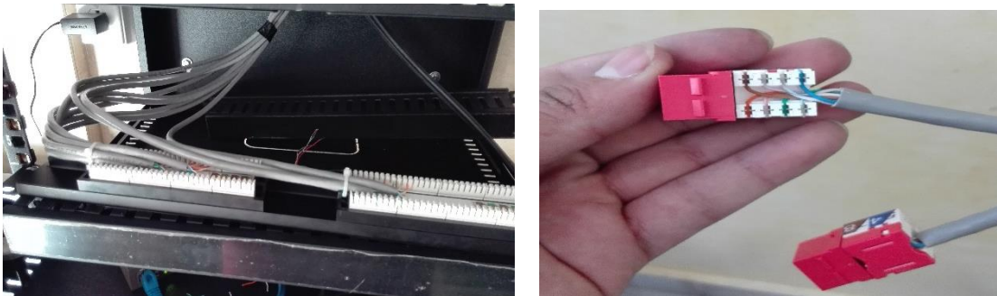
Figura 4.34 Ponchada configuración (T568B).
