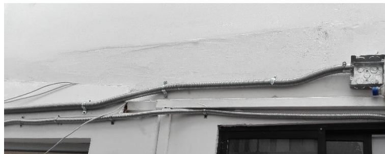
Figura 4.27 Instalación manguera BX Planta Alta 1.
