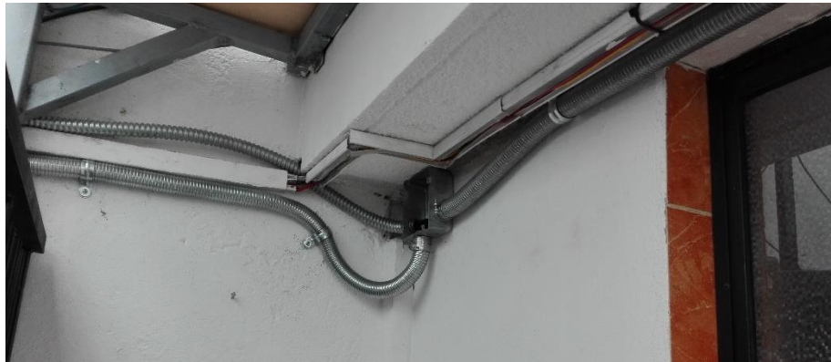
Figura 4.26 Instalación manguera BX Planta Alta 1.
