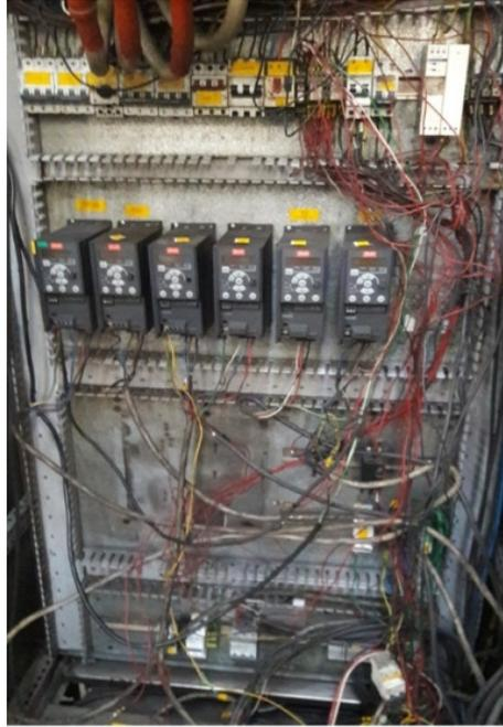
Figura 4.63. Desmontaje Tablero Original
