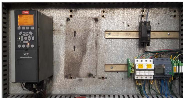
Figura 4.35. Variadores de Frecuencia Control Manual
