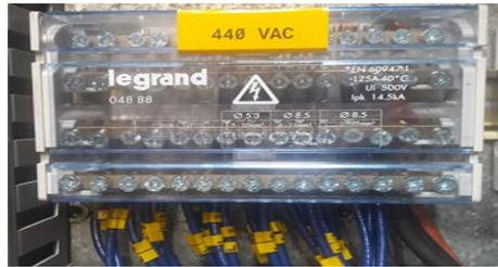
Figura 4.67. Distribuidor de Carga 440 Vac
