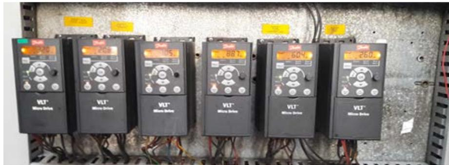
Figura 4.34. Variadores de Frecuencia Control Manual
