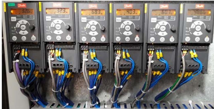
Figura 4.71. Conexión Red Modbus
