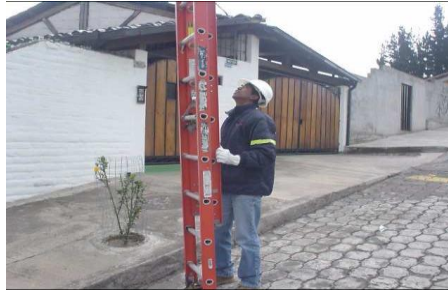
Figura 6. Colocación de la Escalera
