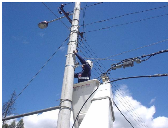
Figura. 5. Colocación de la abrazadera
