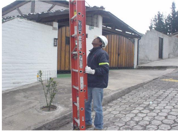
Figura. 3 Fijación de la escalera
