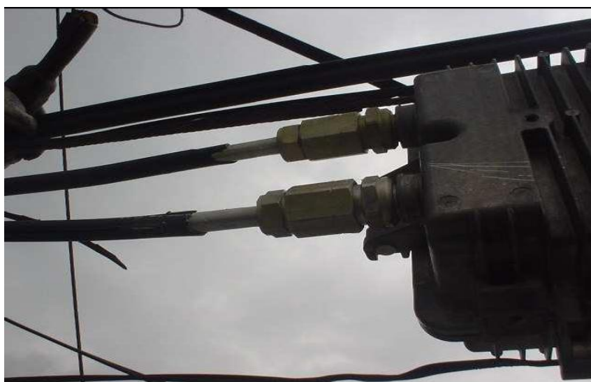
Figura 8. Colocación de mangas.
