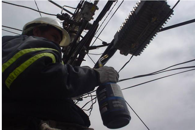
Figura. 13. Quemar el tubo termorretráctil
