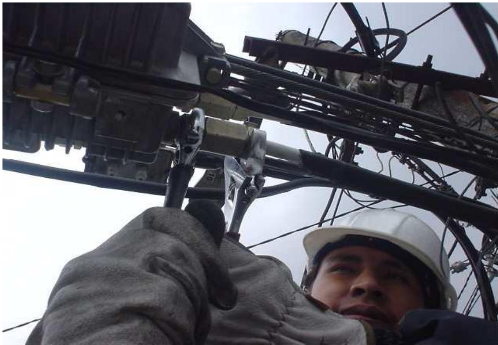
Figura 9 Colocación del amplificador.
