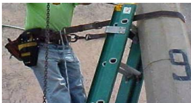
Figura 1. Colocación de la Escalera.
