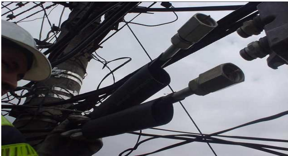
Figura 12. Colocación de Conectores
