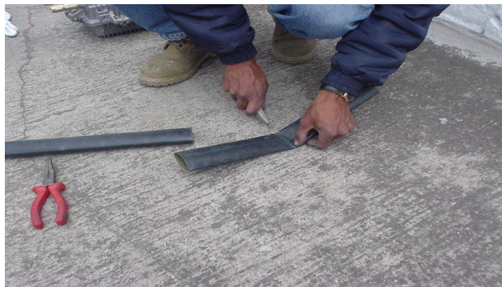
Figura. 10. Cortar el tubo termorretráctil
