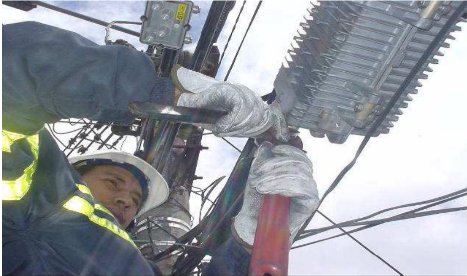
Figura 13 Colocación del amplificador.
