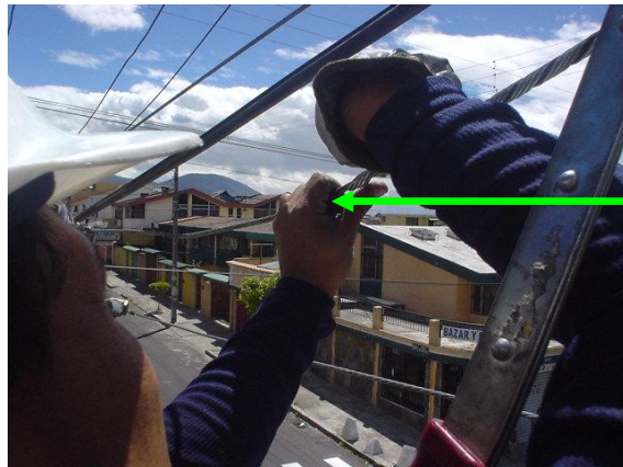
Figura. 9. Sujetar el mensajero del cable 500
