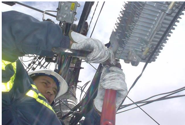
Figura. 12. Instalación de los elementos de la red
