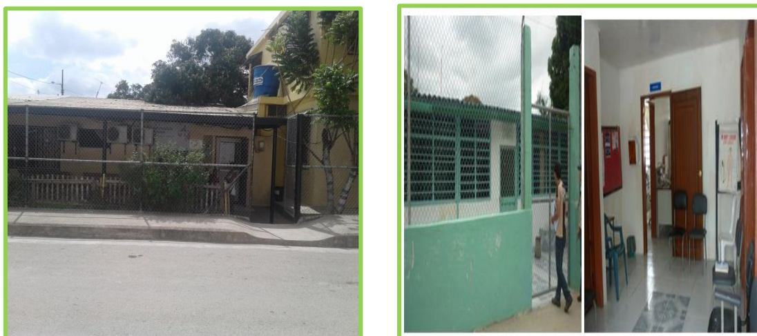
Figura 1. Vista frontal e interna -Sub- Centro de Salud Pública de Tonsupa. Fuente (Gadtonsupa.gov.ec, Gadtonsupa, 2015)
