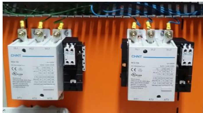
Figura 35. Instalación de contactores (Fuente: Elaboración propia)
