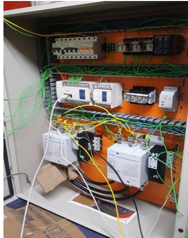
Figura 39. Cableado e instalación del sistema eléctrico (Fuente: Elaboración propia)
