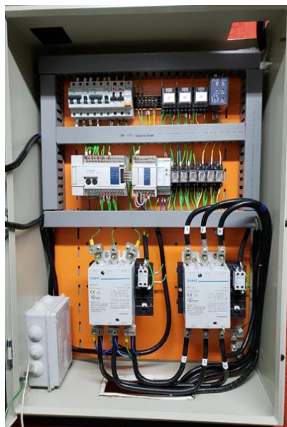
Figura 40. Instalación y conexión de cables de potencia para la carga (Fuente: Elaboración propia)
