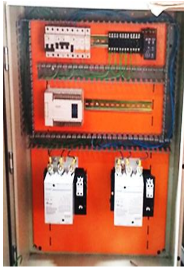
Figura 38. Instalación de elementos electrónicos y eléctricos (Fuente: Elaboración propia.)
