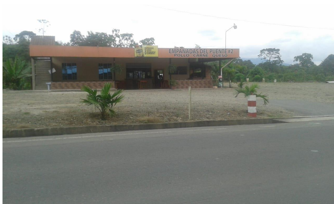
Figura 34. Empanadas del "Puente 2"
