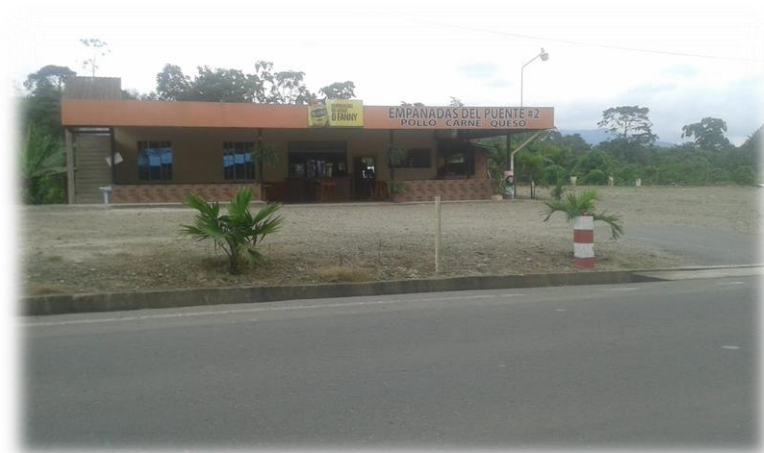
Figura 17. Local restaurante "Empanadas del puente N° 2"
