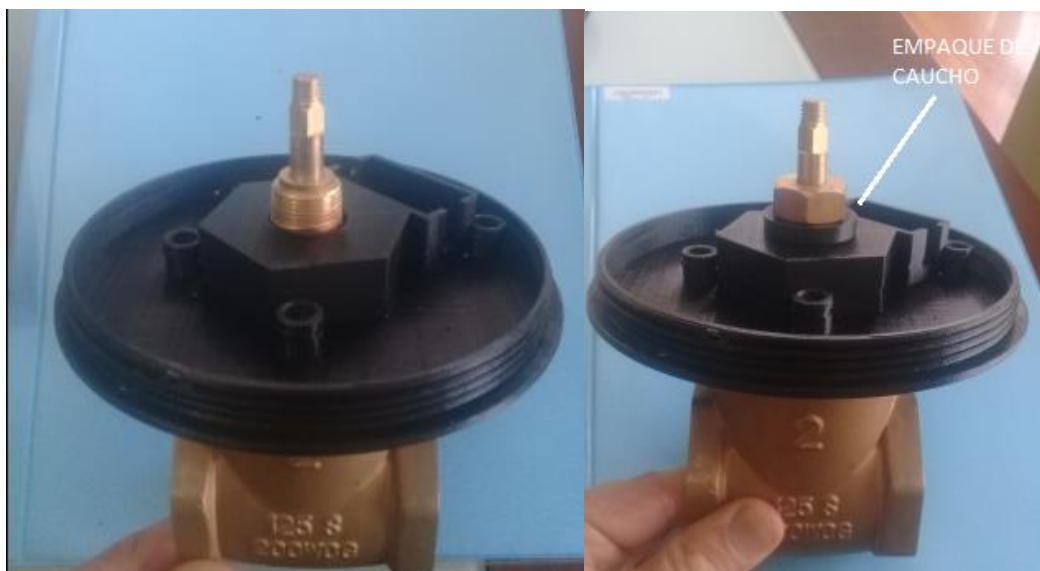
Figura. 4.32 Montaje de la base sobre la válvula.
