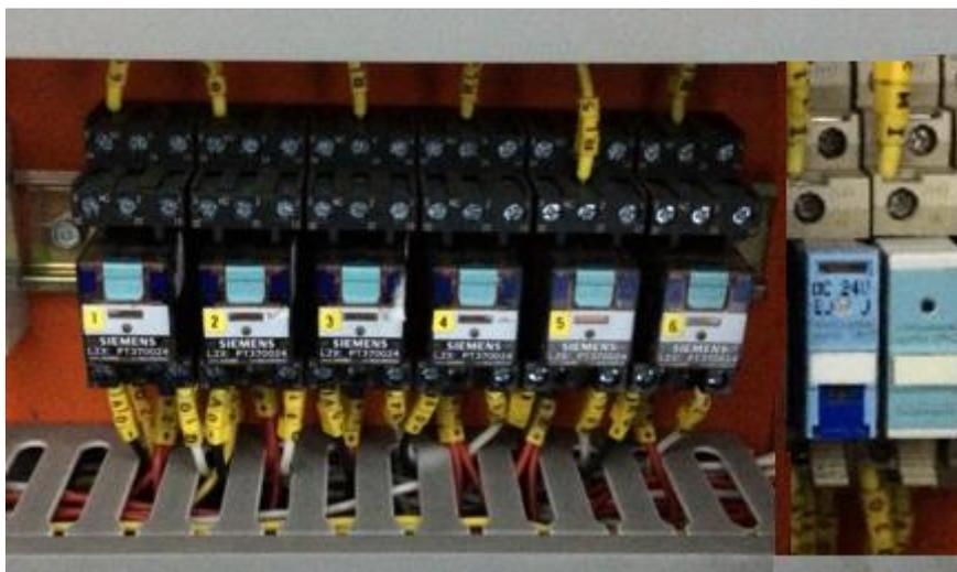
Figura 4. 17 Relés principales y auxiliares utilizados en el proyecto
