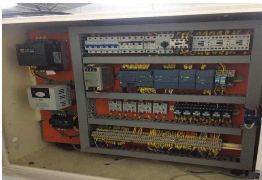
Figura 4. 23 Tablero de Control luego de la implementación
