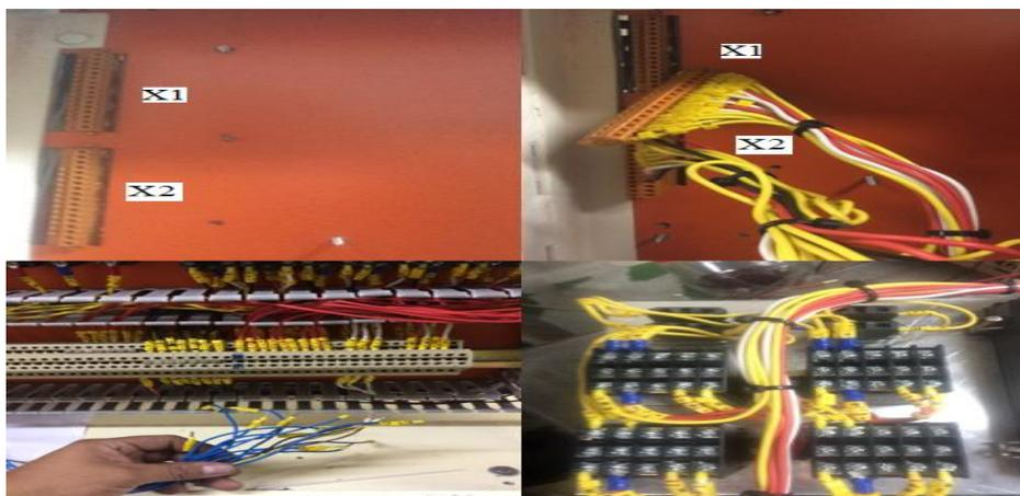
**Figura 4. 19 Nomenclatura de Borneras Principales y Marquillado General**
