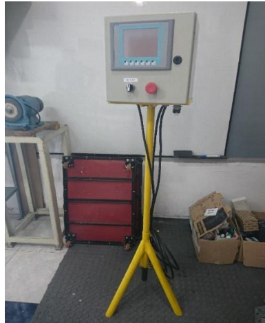
Figura 4.6. Colocación de tablero de control en pedestal telescópico
