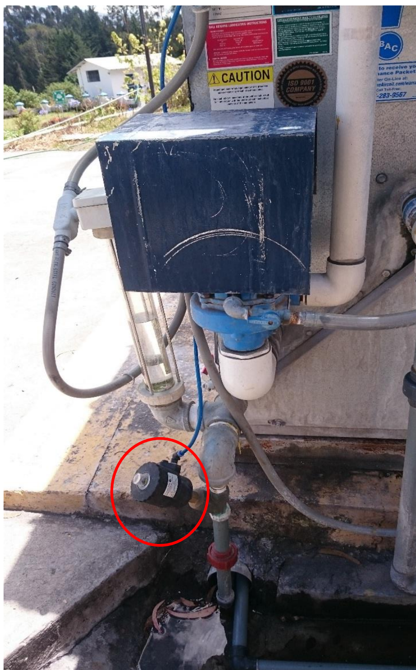
Fig. 4.6 Electroválvula DANFOSS
