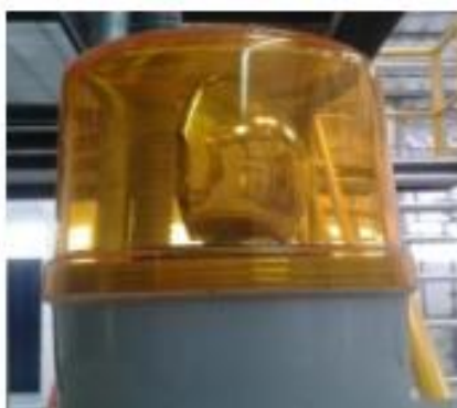
Fig. 3.36 Luces piloto de alarma
