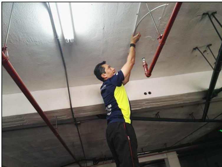
Figura 3.46. Instalación de canaleta plástica
