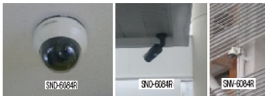
FIGURA 30. CÁMARAS USADAS EN EL SISTEMA DE CCTV PLATAFORMA. Fuente: AUTOR.
