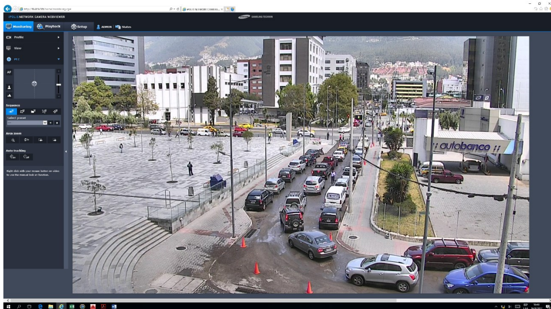
FIGURA 42. CÁMARA EXTERIOR TIPO PTZ UBICADA EN FACHADA PRINCIPAL DE LA CALLE AMAZONAS. Fuente: AUTOR.
