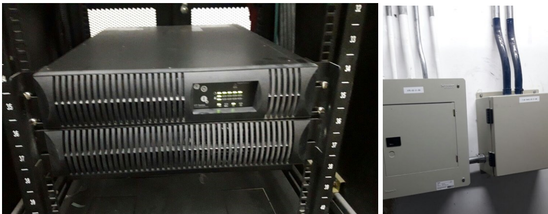
FIGURA 27. SISTEMA ELÉCTRICO REGULADO PARA RED DE CCTV. Fuente: AUTOR.
