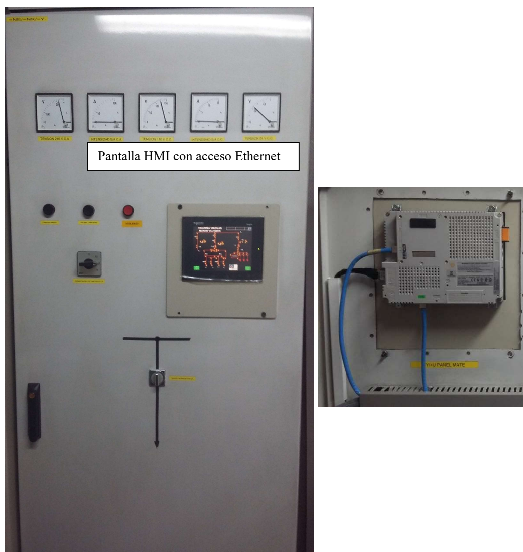
Figura 3.114. Panel Frontal de NENK y Posterior con la Pantalla HMI.
