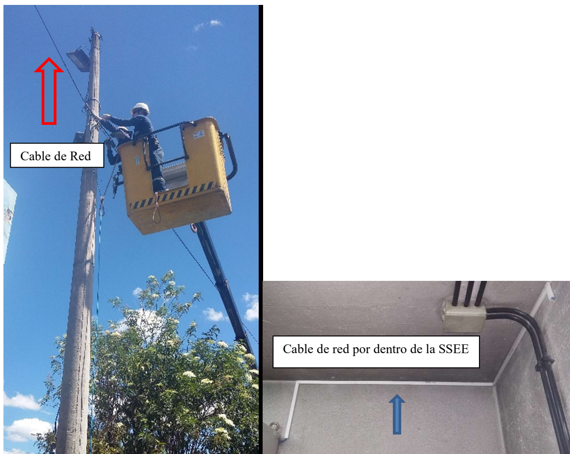
Figura 3.111. Instalación de la Acometida de Red Ethernet.
