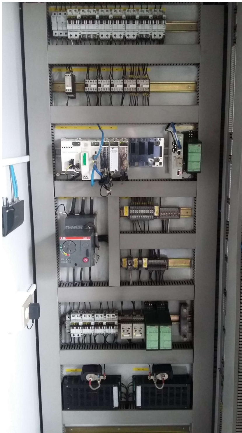
Figura 3.129. Estado del Interior de la Celda NENK al Finalizar la Implementación.
