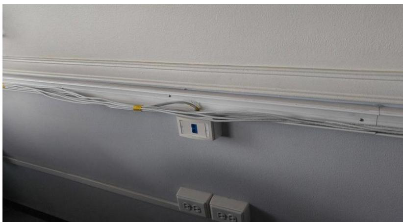
Figura 49 Colocación de los cables de red y cajetines
