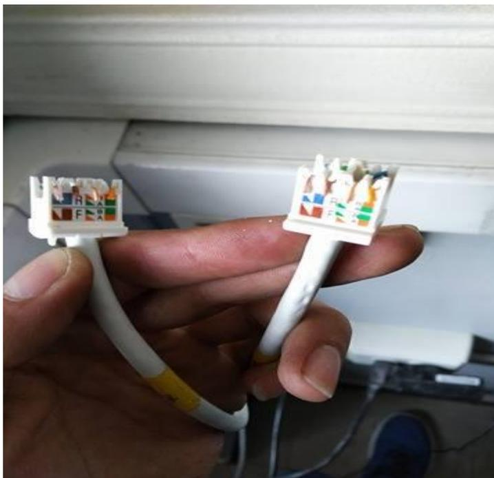
Figura 51 Colocación del cable de red en el Jack
