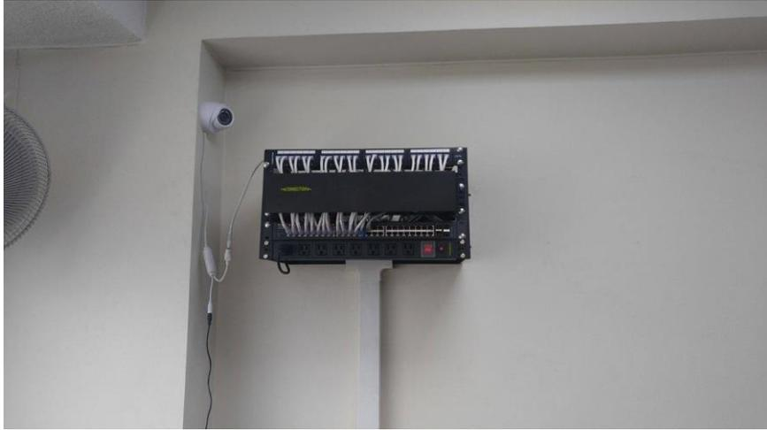
Figura 55 Armado final del rack
