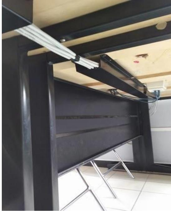
Figura 50 Canaletas metálicas
