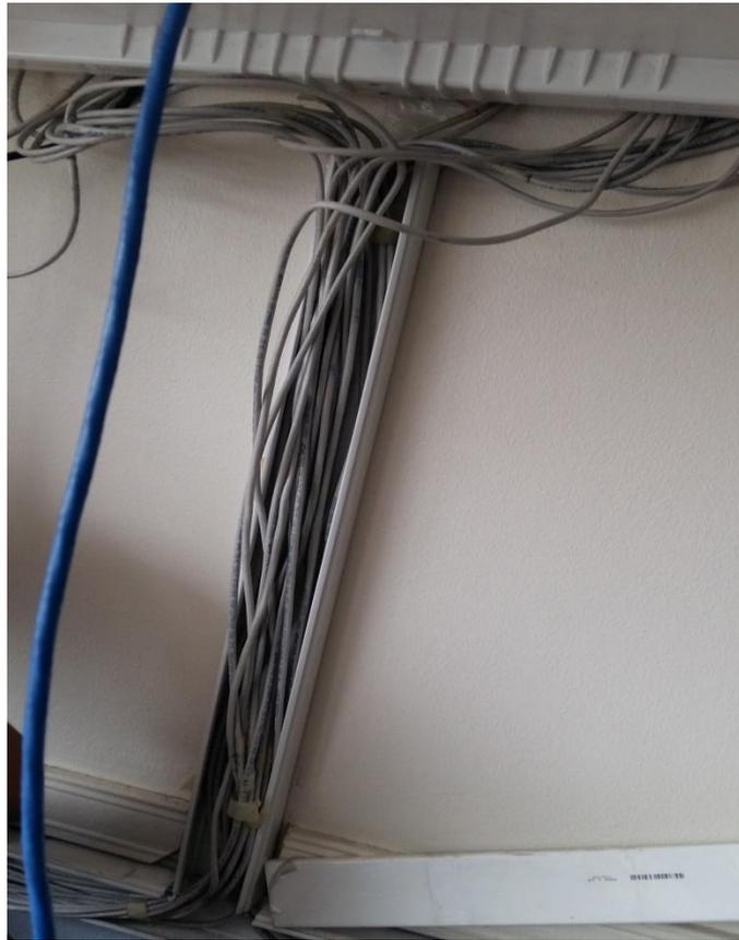
Figura 46 Desmontaje del cable de red
