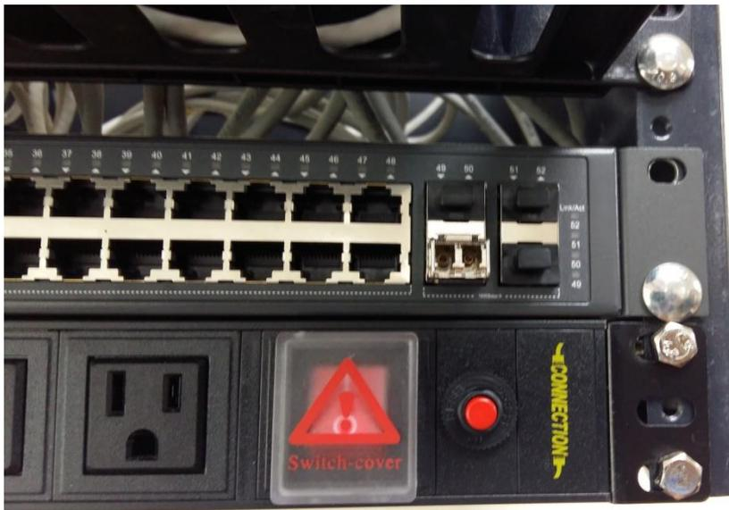
Figura 54 Colocación del Módulo SFP
