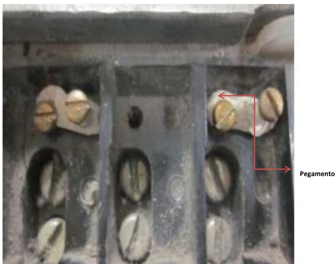
Figura. 101. Aldaba aislada Infracción al servicio (EEQ, 2015)
