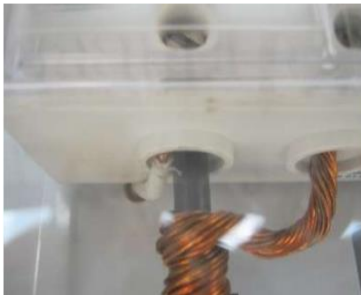
Figura. 123. Derivación Directa Infracción al servicio (EEQ, 2015)
