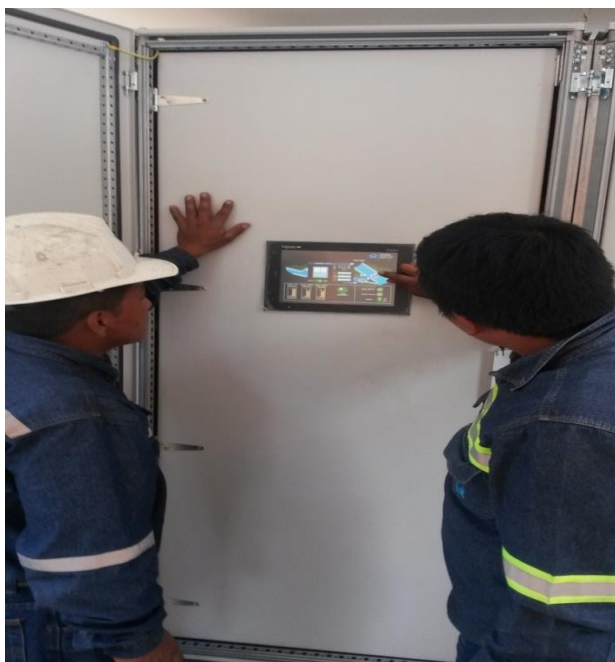
Figura 77. Pruebas de funcionamiento del HMI en el sitio de operación
