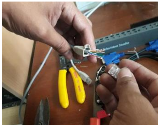
Figura 27. Instalación del cableado de red.
