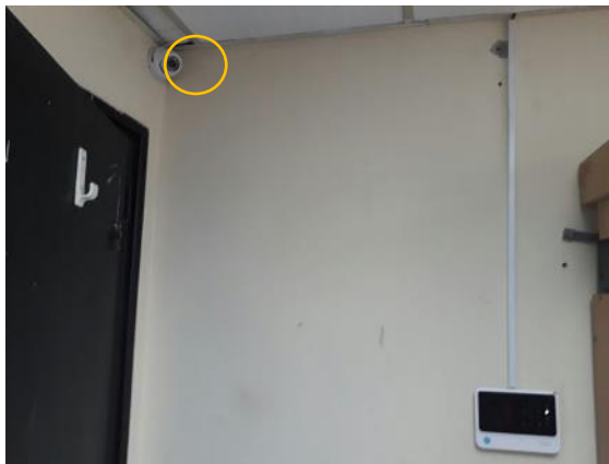
Figura 21. Ubicación de la cámara 1.
