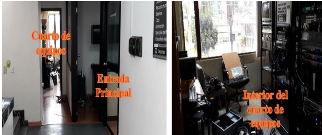
Figura 26. Vista del pasillo de acceso y el interior del cuarto de equipos.
