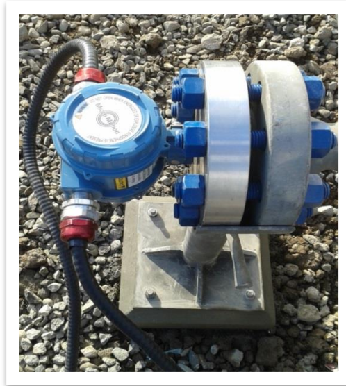
Imagen 38: Ajuste de bridas dispositivo de densidad
