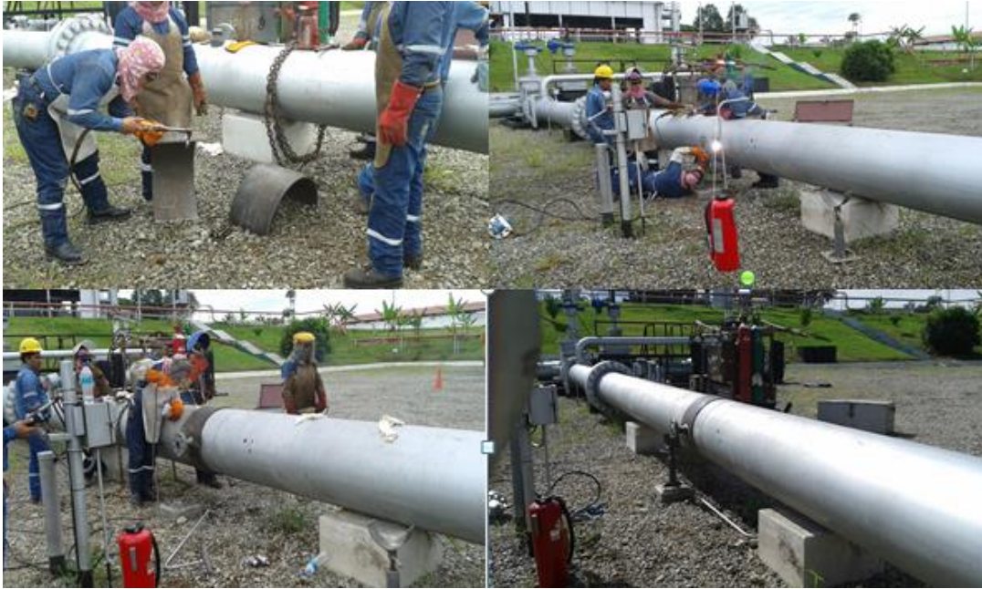
Imagen 37: Procedimiento de suelda brida y camisa de refuerzo
